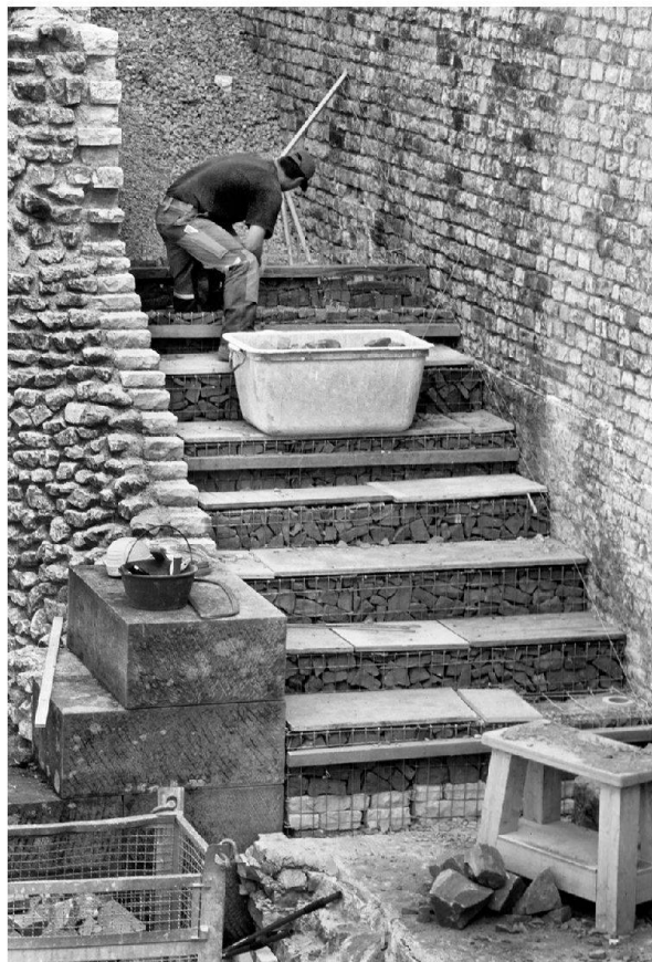
Abb. 33: Augst, Theatersanierung (Grabung 2003.55). Südhalle: Treppe zum Diazoma-Umgang (Umgang der ersten praecinctio). Die Gitterkorbkonstruktion der modernen Treppe im Aufbau.
