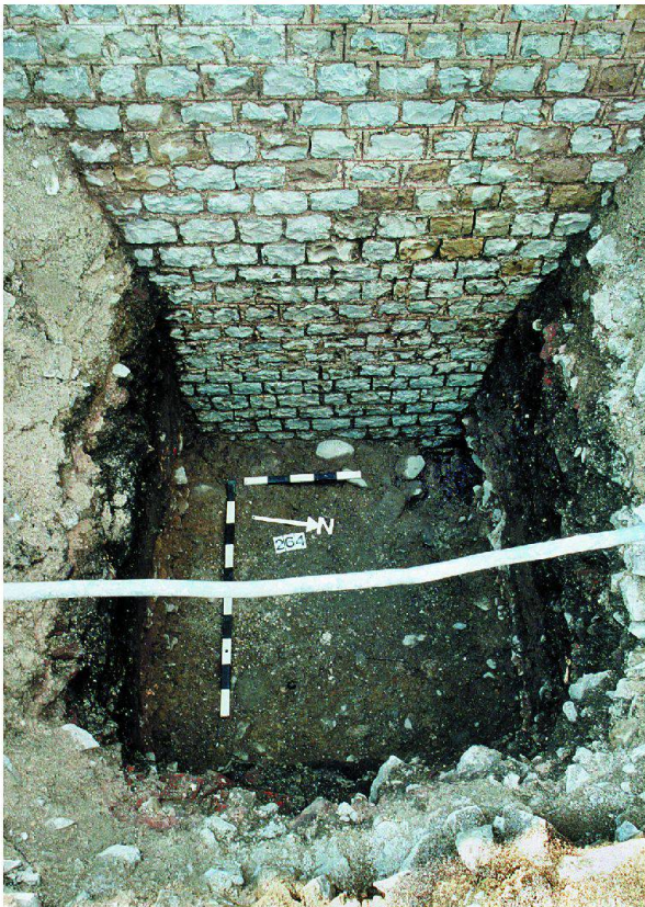
Abb. 4: Augst, Theatersanierung (Grabung 2003.55). Peripheriemauer (MR 58) Keil 3. Sondierloch an der Peripheriemauer, Übersicht. Zweiphasiger, gut erhaltener, rot bemalter Fugenstrich in situ an der Mauerchale von MR 58.
