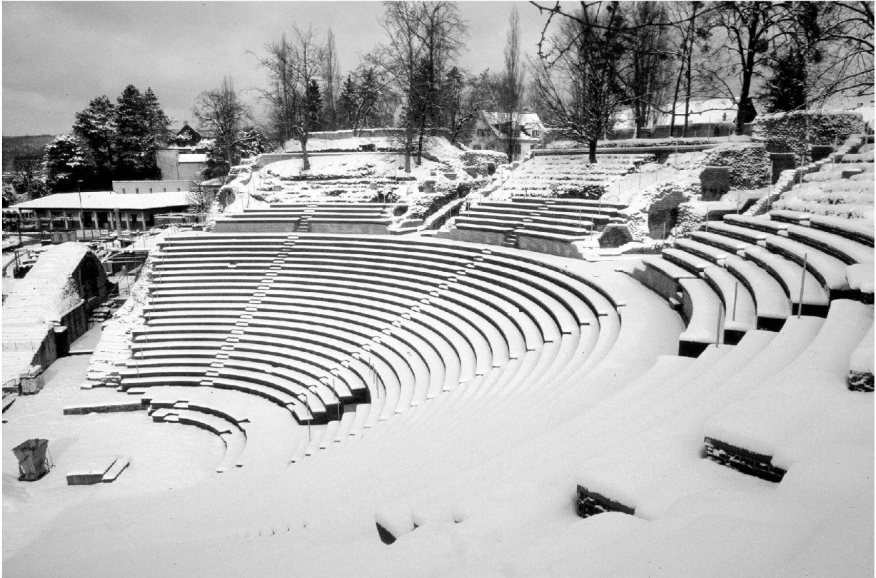
Abb. 26: Augst, Theatersanierung (Grabung 2003.55). Rekonstruktion der Sitzstufen im ersten Rang. Winterimpressionen; Nordhälfte der fertiggestellten Sitzstufenrekonstruktion.
