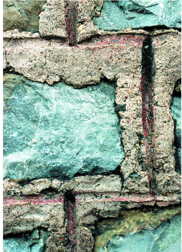
Abb. 3: Augst, Theatersanierung (Grabung 2003.55). Peripheriemauer (MR 58) Keil 3. Detail des hervorragend erhaltenen Fugmörtels mit eingedrücktem, U-förmigem Fugenstrich und dunkelroter Bemalung (Bereich der oberen, originalen Zone).
