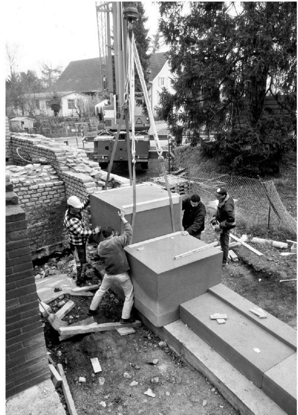
Abb. 39: Augst, Theatersanierung (Grabung 2003.55). Umgebungsgestaltung. Ersatz und Korrektur der bereits von Rudolf Laur-Belart ausgeführten Schwellenkonstruktion am Eingang zum Mittelvomitorium. Auf Grund der jüngsten Grabungen sowie des Studiums der alten Grabungsakten aus dem späten 16. und dem frühen 20. Jahrhundert liess sich der Aufbau der massiven Schwellenkonstruktion recht genau rekonstruieren. Das Versetzen der grossen Buntsandsteinquader – einzelne Blöcke erreichten ein Gewicht von bis zu vier Tonnen – erforderte einiges an Ideenreichtum und Fingerspitzengefühl.
