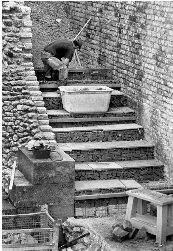
Abb. 33: Augst, Theatersanierung (Grabung 2003.55). Südhalle: Treppe zum Diazoma-Umgang (Umgang der ersten praecinctio). Die Gitterkorbkonstruktion der modernen Treppe im Aufbau.
