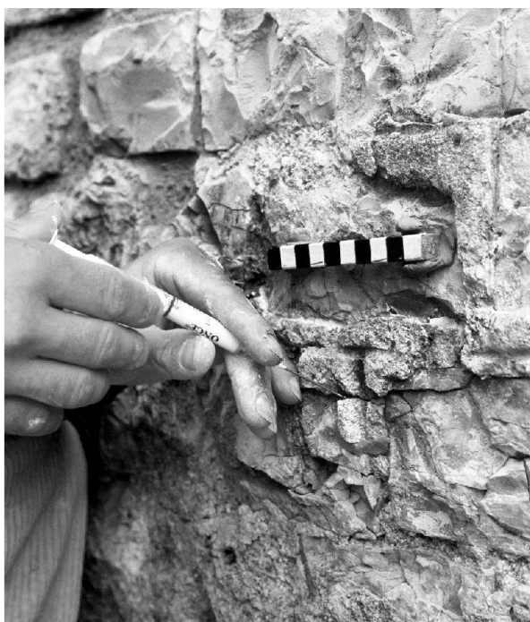
Abb. 37: Augst, Theatersanierung (Grabung 2003.55). Sanierung originaler Mauerschalen. Sicherung antiker Fugenstrichpartien an der südlichen Caveaabschlussmauer 107. Lose Fugmörtelstücke wurden zurückgeklebt, hohle Stellen ausinjiziert und ausgebrochene Mörtelpartien mit Restauriermörtel neu verfügt.
