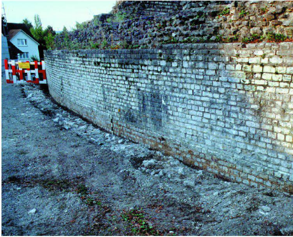
Abb. 2: Augst, Theatersanierung (Grabung 2003.55). Peripheriemauer (MR58) Keil 3. Übersicht über die freigelegte Sockelzone mit hervorragend erhaltenem, rot bemaltem Fugenstrich im Bereich der untersten 30 cm.
