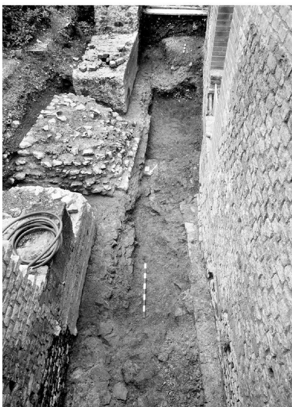
Abb. 13: Augst, Theatersanierung (Grabung 2003.55). Schwellensituation des Mittelvomitoriums. Der Baubefund im Überblick von Nordosten. Gut erkennbar das breite Schwellenfundament, das nachträglich zwischen die beiden Peripheriemauerabschnitte MR 57 und MR 58 gesetzt ist. Am Mauerklotz der Zwischenmauerung ist noch schwach der Negativabdruck eines geraubten Gewändequaders zu erkennen. Am rechten Bildrand die innere Peripheriemauer 55 mit den darunter sichtbaren Mauerzügen einer älteren Bauphase (vgl. Abb. 14).
