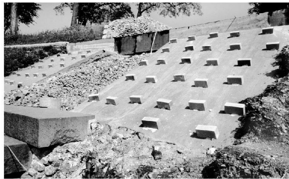
Abb. 30: Augst, Theatersanierung (Grabung 2003.55). Rekonstruktion der Sitzstufen im zweiten Rang. Zone der Betonüberwölbung des Südost-Vomitoriums; Unterkonstruktion als Sicherung gegen das Abrutschen der darüber folgenden 28° steilen Erdböschung.
