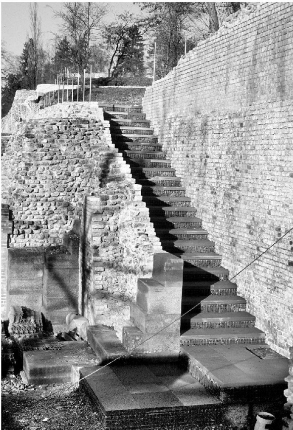
Abb. 32: Augst, Theatersanierung (Grabung 2003.55). Südhalle: Treppe zum Diazoma-Umgang (Umgang der ersten praecinctio). Fertiggestellte Treppenkonstruktion an der südlichen Caveaabschlussmauer 107.
