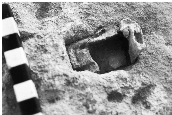
Abb. 4: Augst, Augusta Raurica, Theatersanierung. Detail der Bauklammer-Verbleiung in einem Gurtquader aus Buntsandstein des Dritten (Szenischen) Theaters (Abb. 3; Verbleiung = Kat. 1). M. ca. 3:4.
