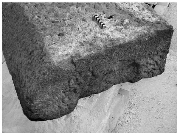
Abb. 3: Augst, Augusta Raurica, Theatersanierung. Übersicht des Gurtquaders des Dritten (Szenischen) Theaters mit Klammer-Verbleiung (= Kat. 1; rechts neben dem Massstab). Siehe Detail Abb. 4. Ohne Massstab.
