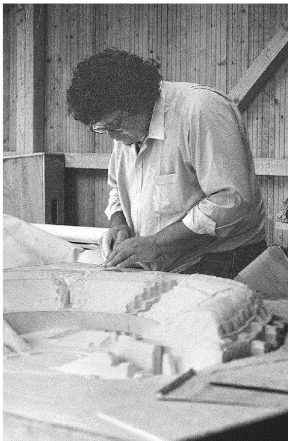
Abb. 6: Augst, Augusta Raurica. Eine grosse Vorliebe und Geschicklichkeit entwickelte Markus Horisberger im Modellbau. Das Gipsmodell des Augster Theaters im Massstab 1:100 war während über zehn Jahren ein wichtiges Planungsinstrument für die Sanierungsarbeiten. Es ist bis 2006 noch im Informationspavillon vor der Theaterbauhütte zu sehen.
