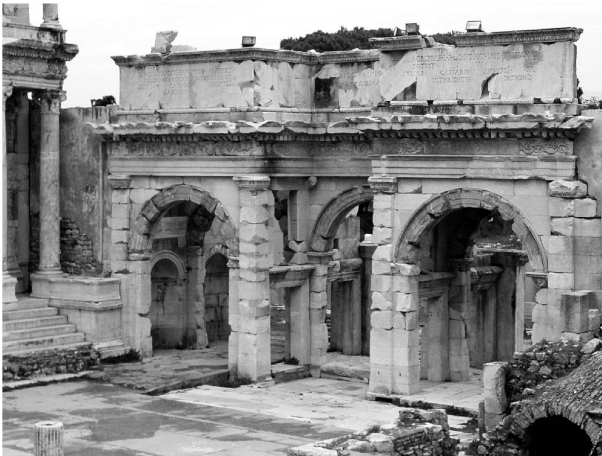
Abb. 3: Ephesus/Türkei. Doppeltor des Mazaeus und Mithridates neben der berühmten Celsus-Bibliothek (am linken Bildrand). Durch das Tor gelangt man zur Handelsagora. An dieser Rekonstruktion mit vielen originalen Bauteilen («Anastylose»), die unter der Federführung des Österreichischen Archäologischen Instituts entstand, war Markus Horisberger als technischer Leiter wesentlich beteiligt.
