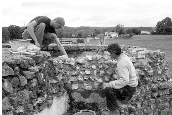
Abb. 51: Augst, Augusta Raurica. Konservierungsarbeiten am Podium des Grienmatt-Tempels durch Pascal Jäger (links) und Avelino Matos de Cruz.
