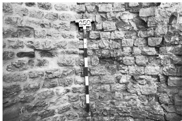
Abb. 38: Augst, Theatersanierung (Grabung 2004.055). Peripheriebereich Keil 3, Mauerinnenschale des Entlastungsbogens MR 131. Am gezeigten Mauerausschnitt lassen sich die verschiedenen Restaurierabläufe erkennen: Am rechten Bildrand ist der Zustand des Mauerwerks vor Beginn der Arbeiten erkennbar; die mit Zement geschlossenen antiken Mauerfugen werden ausgespitzt (Bildmitte), schadhafte Schalenquader geklebt und das Mauerwerk mit dem im Berichtsjahr entsprechend den neuen Erkenntnissen modifizierten Mörtel neu verfugt (linker Bildrand).
