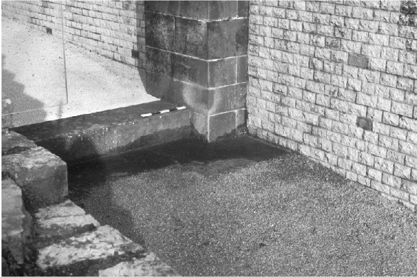
Abb. 27: Augst, Theatersanierung (Grabung 2004.055). Ausgestaltung der Bodenbeläge: Durch die farbliche Variation des Bodenmaterials lässt sich eine didaktische Wirkung erzielen, wie im Bildausschnitt mit dem Übergang vom offenen, mit Sandsteinplatten belegten Bereich der Mündung des Nordaditus zu dem im Hintergrund erkennbaren hellen «Kalkmörtelboden» gezeigt wird. Blick von Süden.
