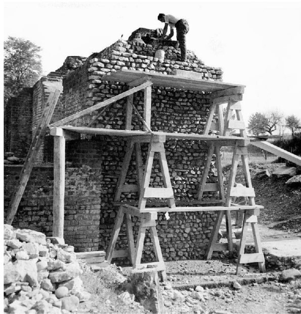
Abb. 20: Augst, Theatersanierung (Grabung 1938.059). Grundlagen zur Erarbeitung eines Auswertungskonzepts. Improvisiertes «Baugerüst» bei den Restaurierungsarbeiten am Nordaditus im Jahre 1938.
