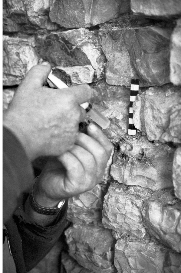
Abb. 40: Augst, Theatersanierung (Grabung 2004.055). Peripheriebereich Keil 3, Mauerinnenschale des Entlastungsbogens MR 131. Detail der Feinrestaurierung von Mauerschalen: Mit einer Spritze wird das Injektionsharz durch den ebenfalls mit dem Heissiegelkleber ausgebildeten «Trichter» in die Haarrisse eines Schalenquaders gepresst.
