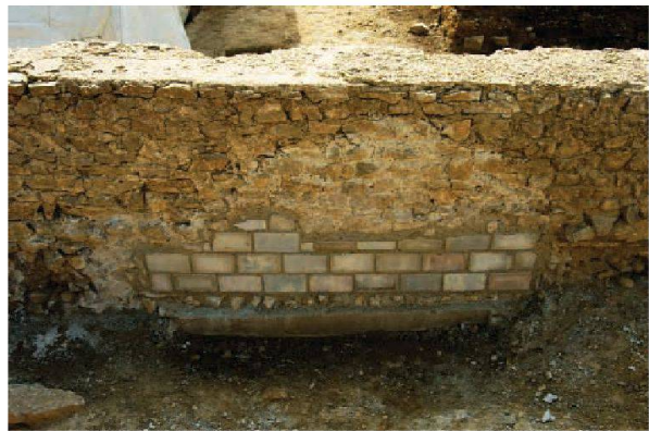
Abb. 64: Augst, Augusta Raurica, Insula 27. Eine andere Mauer (MR 9) mit ähnlicher Konsolidierung des erhaltungsbedingt ausgebrochenen Fundaments mittels moderner Zementbacksteine. Diese werden zwar nicht sichtbar sein, können aber jederzeit vom römischen Original unterschieden werden.
