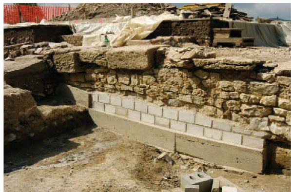
Abb. 63: Augst, Augusta Raurica, Insula 27. Die mit einem Betonfundament und modernen Zementbacksteinen unterfangene Mauer 11 (Abb. 62). Nach Wiederherstellung des Gehniveaus des 3. Jahrhunderts n. Chr. sind nur noch die einst überirdischen «aufgehenden» Mauerteile mit den imposanten Schwellsteinen sichtbar.
