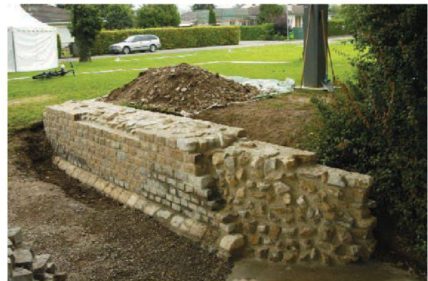
Abb. 60: Augst, Augusta Raurica. Die fertig konservierte Mauer neben der Curia (Abb. 59). Für einen nachhaltigen Schutz ist noch eine partielle Humusabdeckung mit dichtem Grasbewuchs erforderlich (vgl. Abb. 58).
