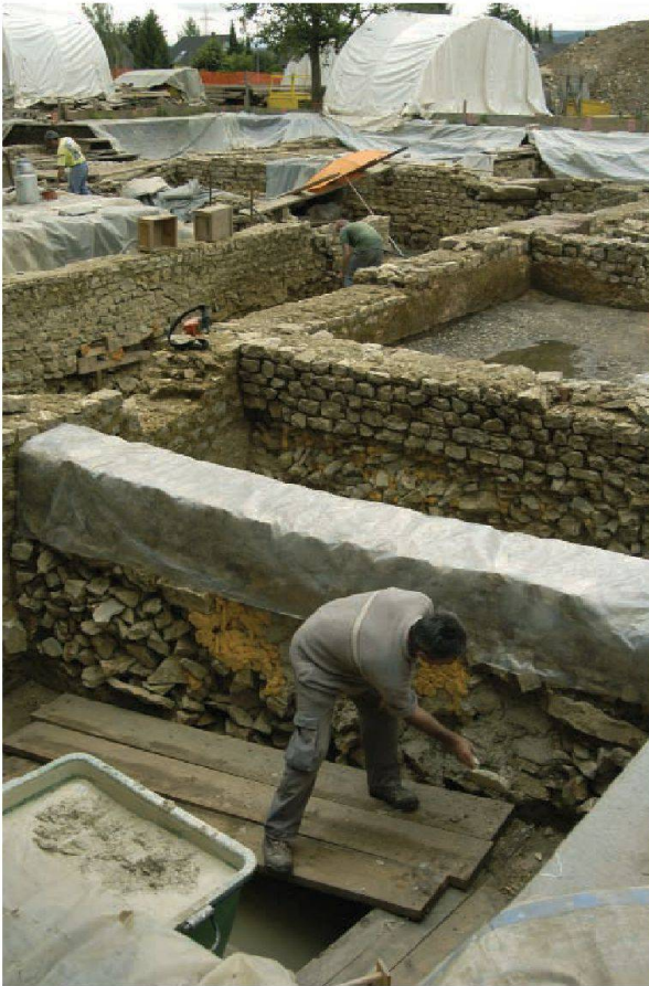
Abb. 61: Augst, Augusta Raurica, Insula 27, Grabung 2005.054. Die etwas besser erhaltenen Mauerpartien mussten (hier durch Antonio Matos de Cruz) in ihrem Fundamentbereich zur Sicherheit beidseitig mit mehreren Schichten Kalkmörtel-Anwurf gefestigt werden.
