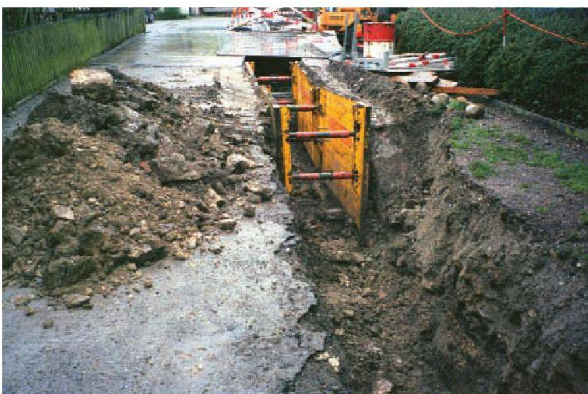
Abb. 8: Augst BL, Schufenholzweg (Grabung 2005.053). Das links und rechts des Grabens liegende Sediment war instabil und brach zeitweise noch während des ersten Ausbaggerns ein, weshalb sofort gespriesst werden musste. Situation im unbefestigten, südlichsten Teil des Schufenholzwegs. Von Süden.
