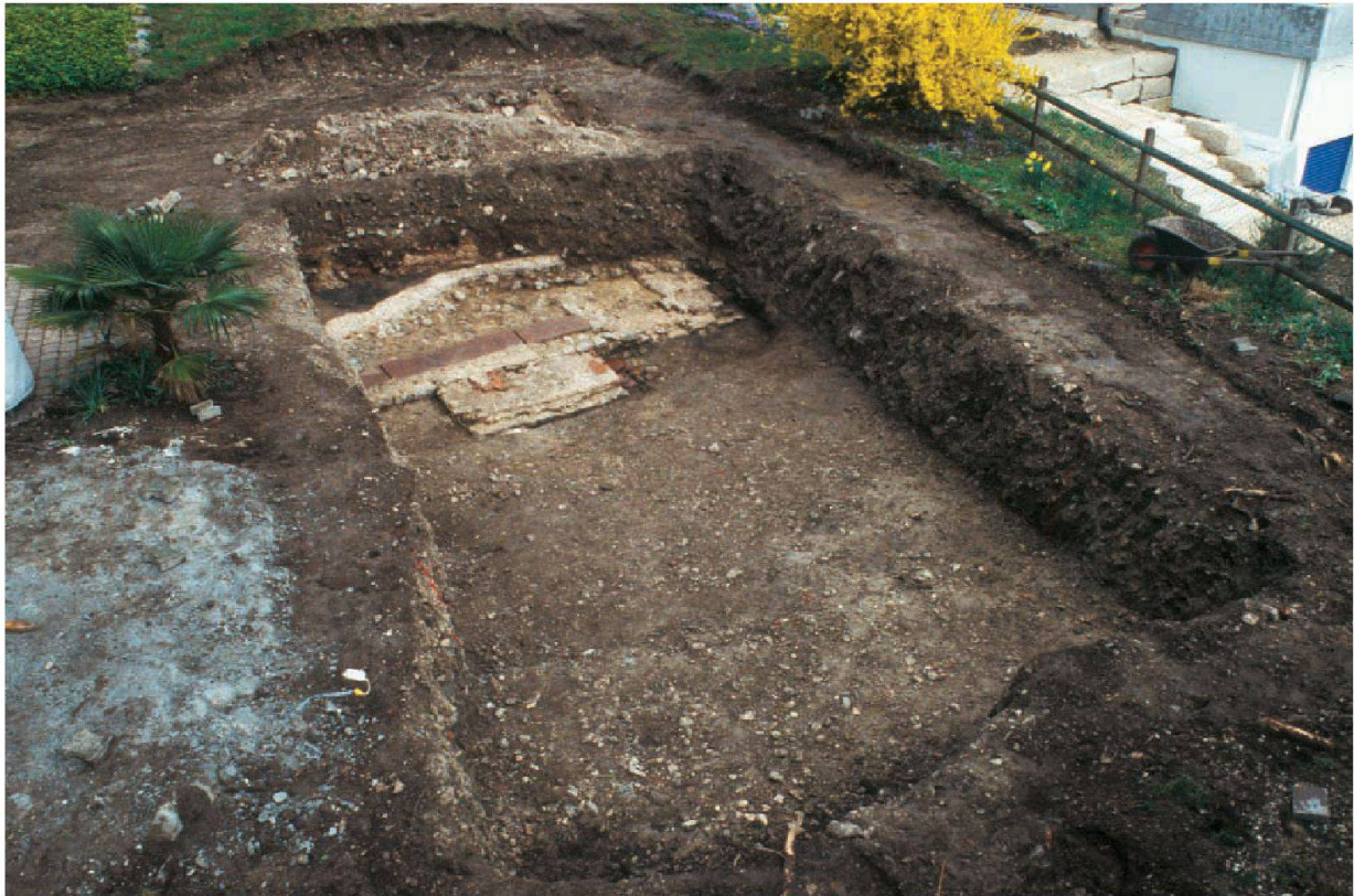
Abb. 3: Augst BL, Schwimmbecken «Distel-Küing» (Grabung 2005.051). Aushubgrube für das geplante Schwimmbecken. Von Nordwesten.
