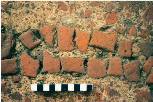
Abb. 11: Augst, Theatersanierung (Grabung 2005.055). Sondagen nordwestliches Vorgelände. Ziegelmosaikboden in Raum 2; Detail der Einlagen aus Ziegeltesserae von 3–4 cm Seitenlänge.
