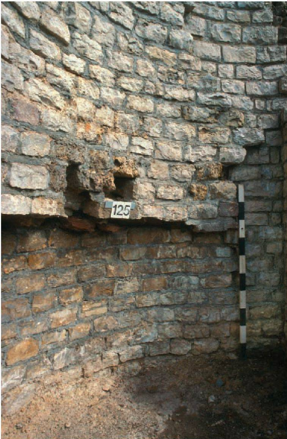
Abb. 36: Augst, Theatersanierung (Grabung 2005.055). Peripherie, Keil 4. Entlastungsbogen MR 141 mit horizontal verschobenem, originale Kalksteinmauerwerk.
