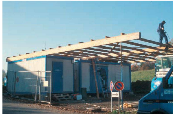
Abb. 55: Augst, Theatersanierung (Grabung 2005.055). Erstellen der redimensionierten, provisorischen Baustelleneinrichtung für die im Jahr 2006 verbleibenden Arbeiten; Aufbau von Büro- und Mannschaftscontainer auf dem Gelände jenseits der modernen Sichelstrasse.
