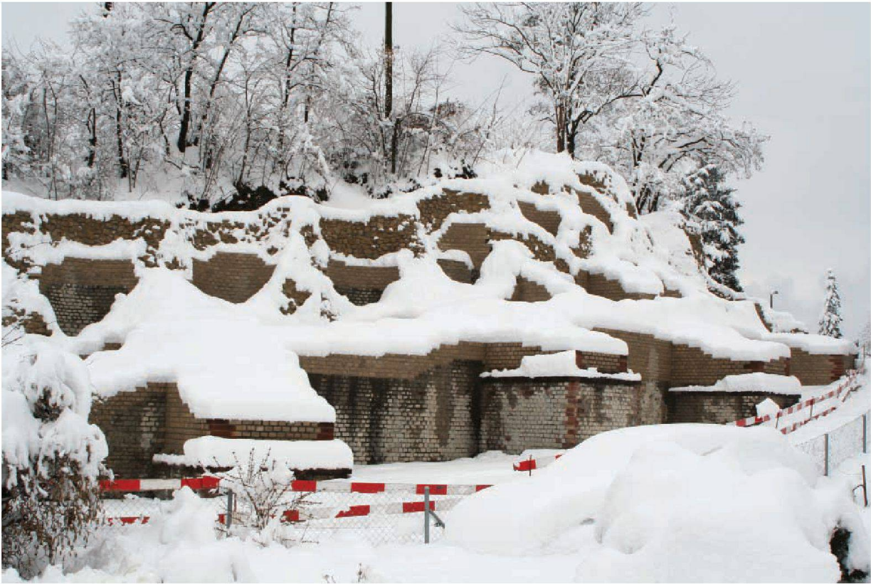
Abb. 42: Augst, Theatersanierung (Grabung 2005.055). Peripherie, Keil 4. Zustand nach Abschluss der Restaurierungsarbeiten.
