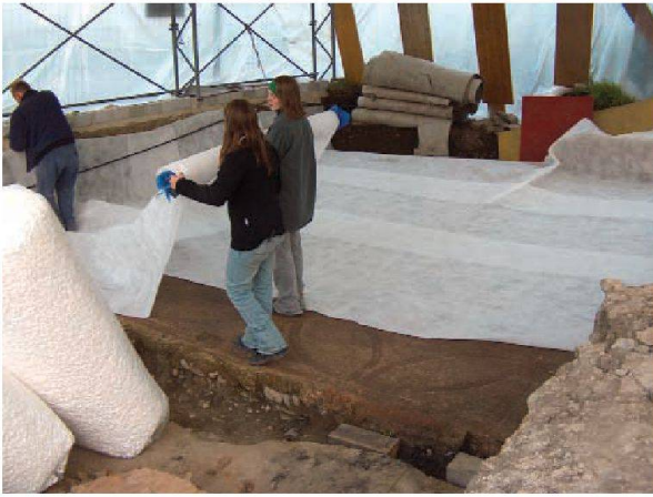
Abb. 49: Augst, Theatersanierung (Grabung 2005.055). Ziegelmosaikboden im nordwestlichen Theater-Vorgelände. Aufbau der provisorischen Wintersicherung, Einbringen des Geovlieses über dem Ziegelestrich durch die Ferienjobberinnen Margareth Warburton und Julia Baumann.
