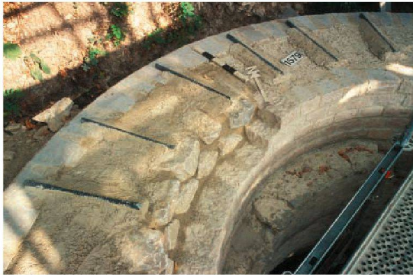
Abb. 39: Augst, Theatersanierung (Grabung 2005.055). Peripherie, Keil 4. Entlastungsbogen MR 141, Aufmauerungsarbeiten. Eingelegte Glasfaserstäbe bewirken eine Druckentlastung der noch erhaltenen Teile der äusseren Mauerschale.
