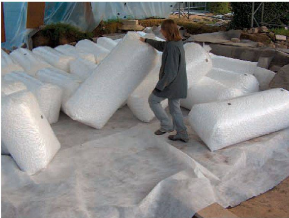
Abb. 50: Augst, Theatersanierung (Grabung 2005.055). Ziegelmosaikboden im nordwestlichen Theater-Vorgelände. Aufbau der provisorischen Wintersicherung, Margareth Warburton verteilt die mit Polysterolchips gefüllten Plastiksäcke als Isolation gegen Frost.
