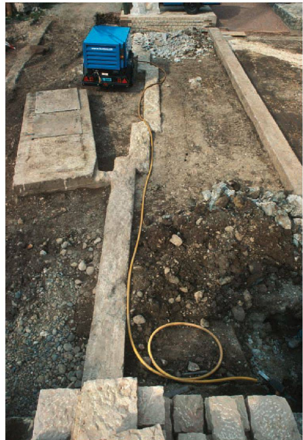
Abb. 44: Augst, Theatersanierung (Grabung 2005.055). Bühnenbereich zwischen MR 1 und MR 44. Reste der Bühnenkonstruktion aus den 1930er Jahren für die Aufführung des « carmen saeculare » von Horaz.
