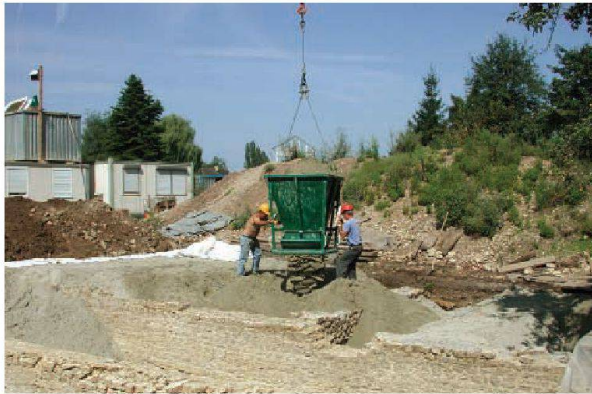
Abb. 6: Augst, Augusta Raurica, Insula 27, Grabung 2005.054. Die Ausgrabung während des Wiedereinfüllens mit Feinsand. Die Mitarbeiter Antonio Matos de Cruz und Avelino Matos de Cruz leeren ein mit Sand gefülltes Betoniersilo über den Ruinen der Insula 27.
