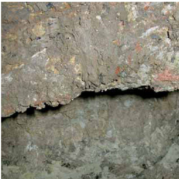
Abb. 24: Kaiseraugst AG, Wacht/Künzli (Grabung 2006.004). Sodbrunnen. Kavemenartige Aushöhlungen.
