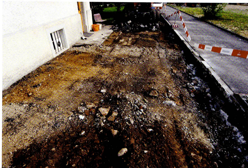
Abb. 25: Augst BL, Degen Zufahrtsstrasse (Grabung 2008.057). Situation nach dem Entfernen des modernen Belags. Der Fotostandpunkt liegt innerhalb des römischen Gebäudes. Gut sichtbar ist die Portikusmauer (auf Höhe des vergitterten Fensters), dahinter schliesst die Fläche der Rauricastrasse an. Von Süden.
