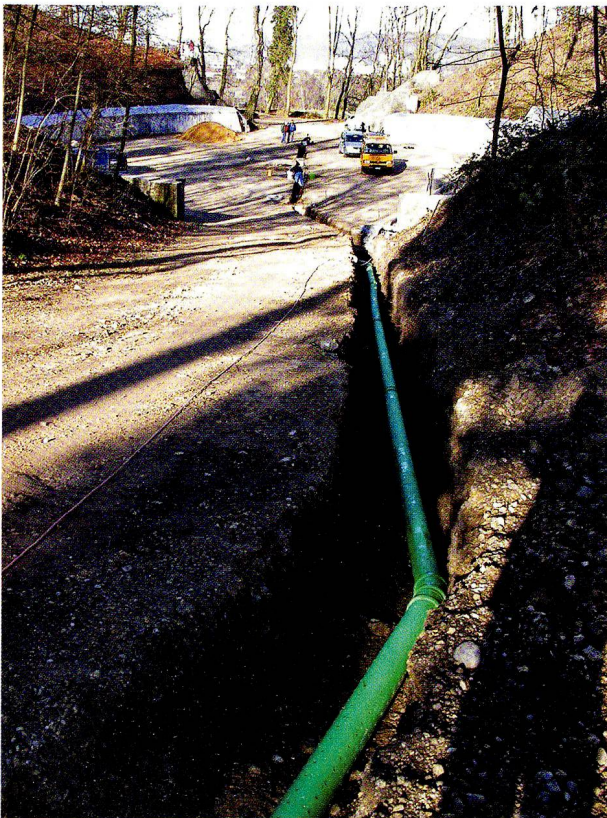
Abb. 11: Augst BL, Amphitheater (Grabung 2008.052). Sickergraben mit eingebauter Leitung an der Kante des modernen östlichen Arenazugangs. Im Hintergrund ist die Arena zu sehen. Von Südosten.
