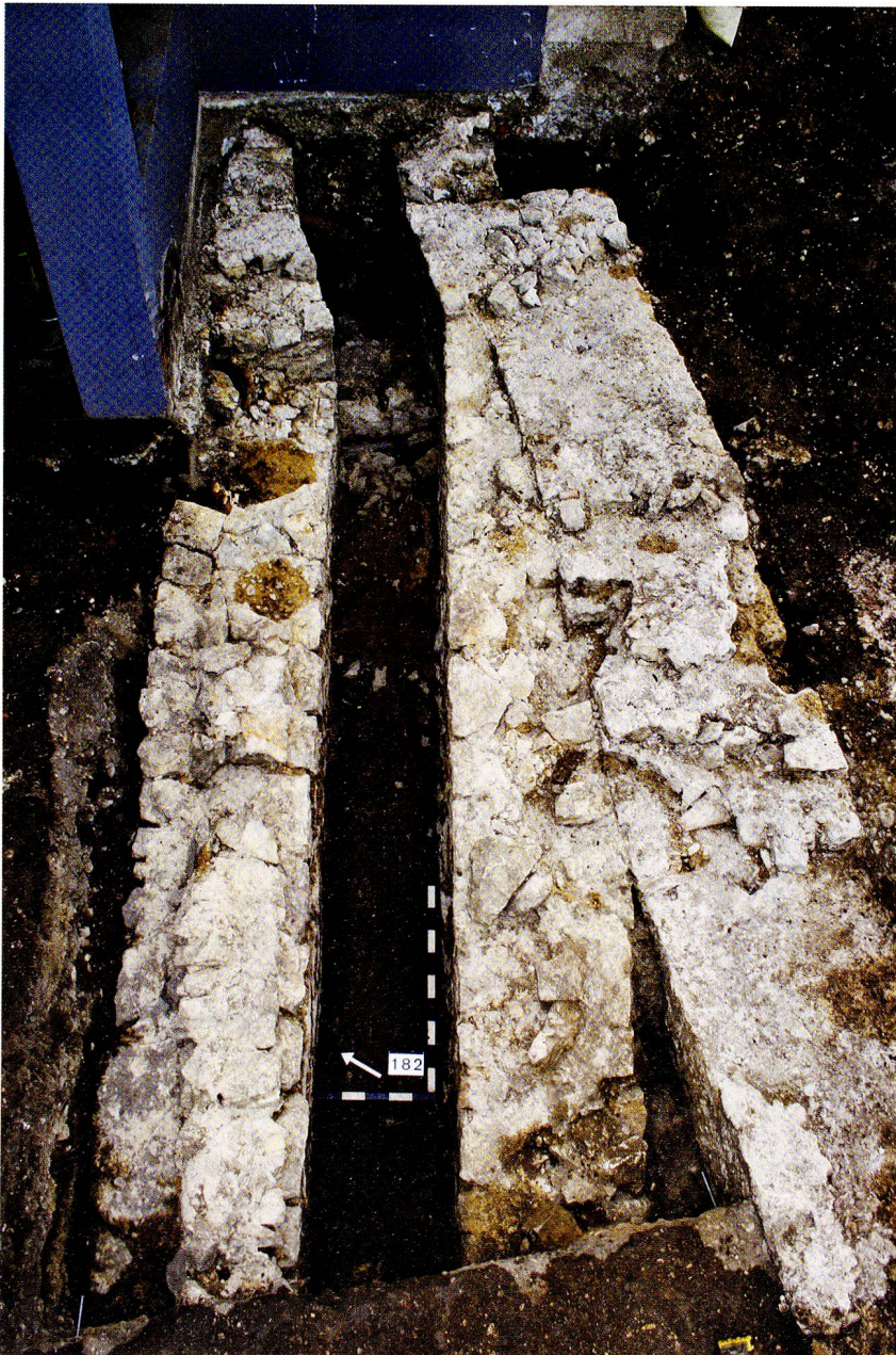
Abb. 17: Augst BL, Sichenstrasse 12 – Südforum (Grabung 2008.053). Blick in den freigelegten Abwasserkanal. Im Hintergrund ist der Durchlass in MR 6 zu erkennen. Im Zentrum befinden sich die beiden Wangenmauern des Kanals mit Resten eines Gewölbes.
