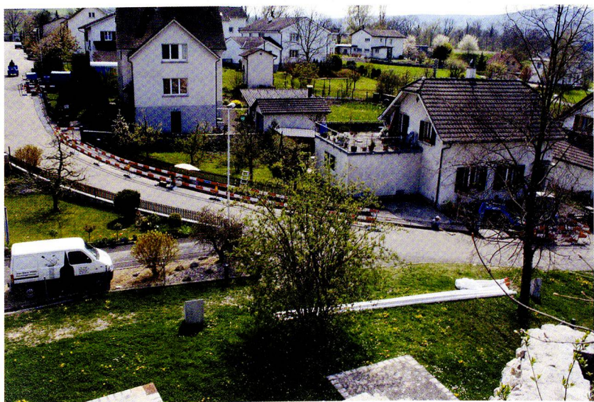
Abb. 24: Augst BL, Schufenholzweg (Grabung 2008.054). Der Leitungsgraben auf einen Blick. Links der bereits wieder verfüllte und mit Belag versehene südliche Teil des Grabens. Der Anfang des Grabens liegt links oben im Bild, wo die blauen Fahrzeuge zu sehen sind, rechts Mitte (beim Bagger) ist das nördliche Ende zu sehen. Blick von Nordosten, aus der Höhe des Szenischen Theaters (Strebepfeilerfundamente im Bildvordergrund).
