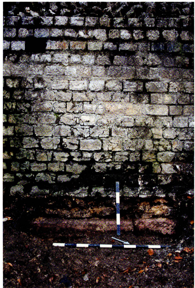
Abb. 9: Augst BL, Amphitheater (Grabung 2008.052). Buntsandsteinblöcke mit Abarbeitungen in der südwestlichen Wangenmauer des Westzugangs. Von Nordosten.
