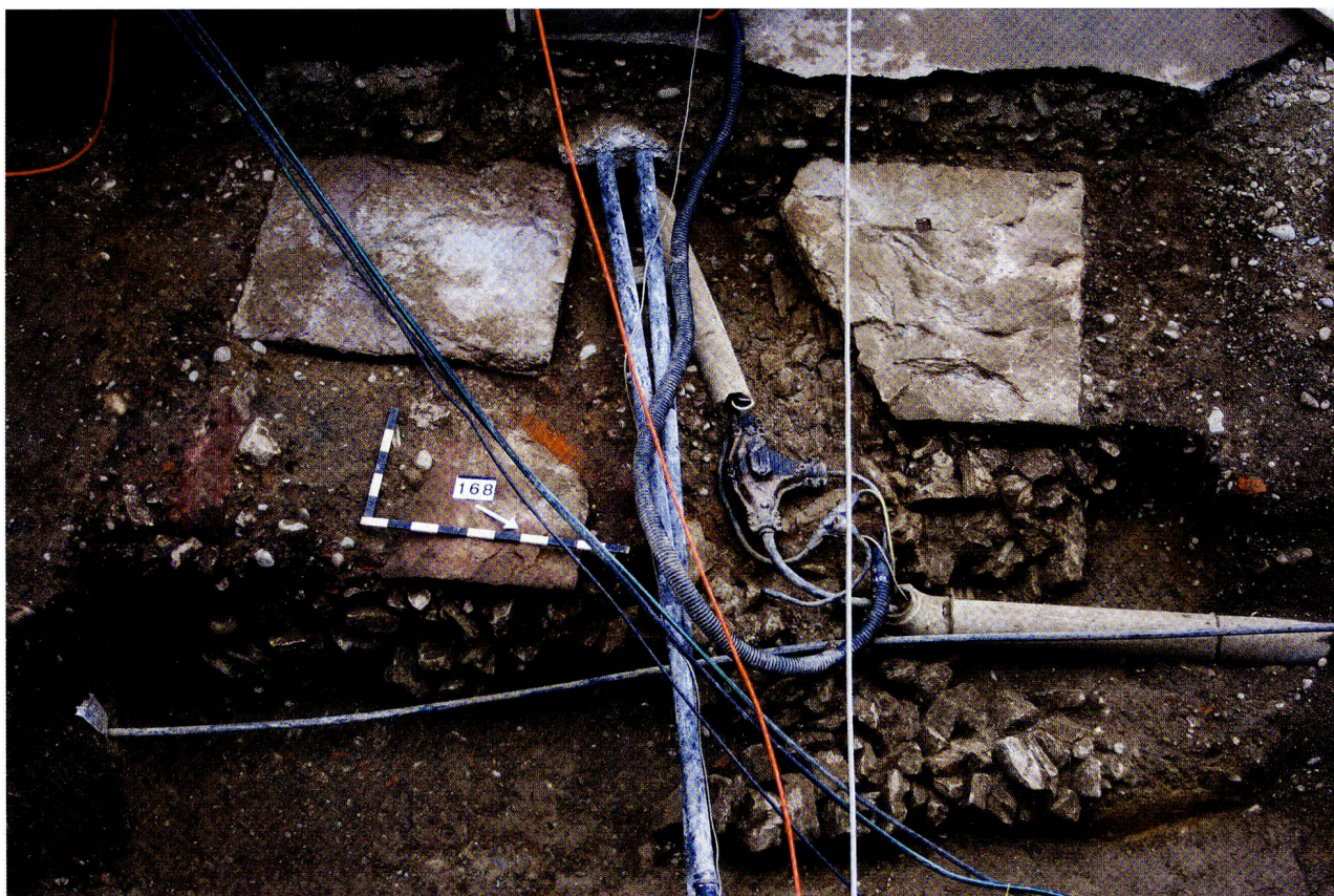
Abb. 37: Augst BL, Elektroleitung E. Frey AG (Grabung 2008.063). Aufsicht auf das durch moderne Leitungen gestörte Brunnenfundament auf der Westseite der römischen Fielenriedstrasse.
