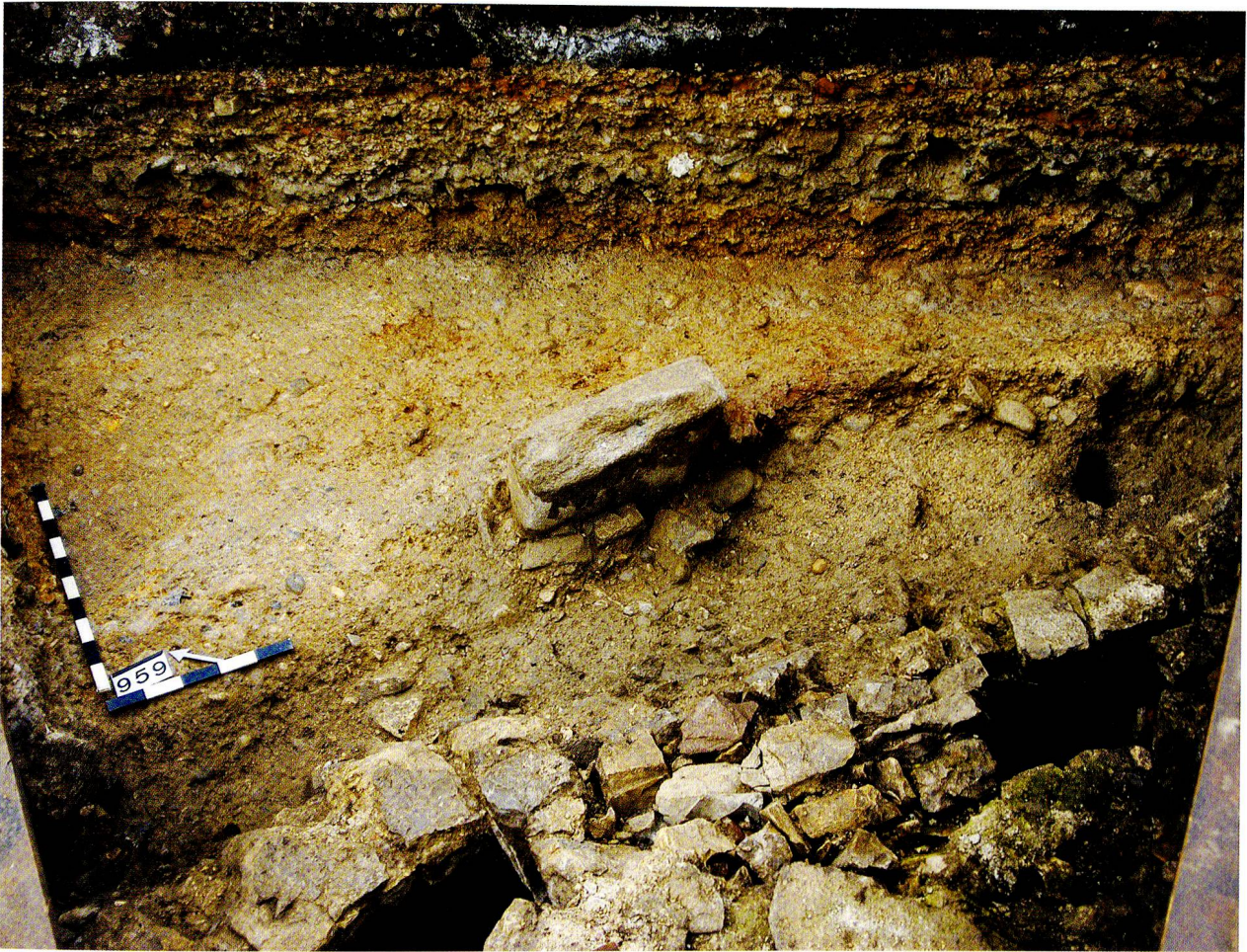
Abb. 13: Augst-Obermühle, Grabung 2006–2007.051. Der grosse Radabweiserstein (Abb. 14) in situ (der Strassenkoffer liegt im Bild oberhalb des Steins). Er bewahrte die Karren vor dem Abrutschen in den anfangs noch offenen Abwasserkanal (Kan ARE9D11.BC.2055). Blick von Westen.
