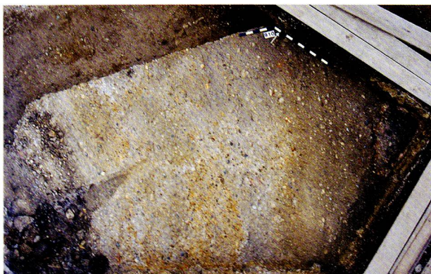
Abb. 16: Augst-Obermühle, Grabung 2006–2007.051. Unterschiedliche verwendete Materialien für den Strassenkoffer der Heilbadstrasse (unten: in Zeitstufe B; oben: in Zeitstufe C).
