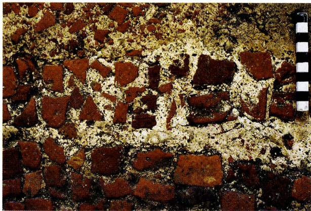
Abb. 5: Augusta Raurica, Region 2A westlich des Theaters. Hellgelber Mörtel im Bereich der Dekorbänder.
