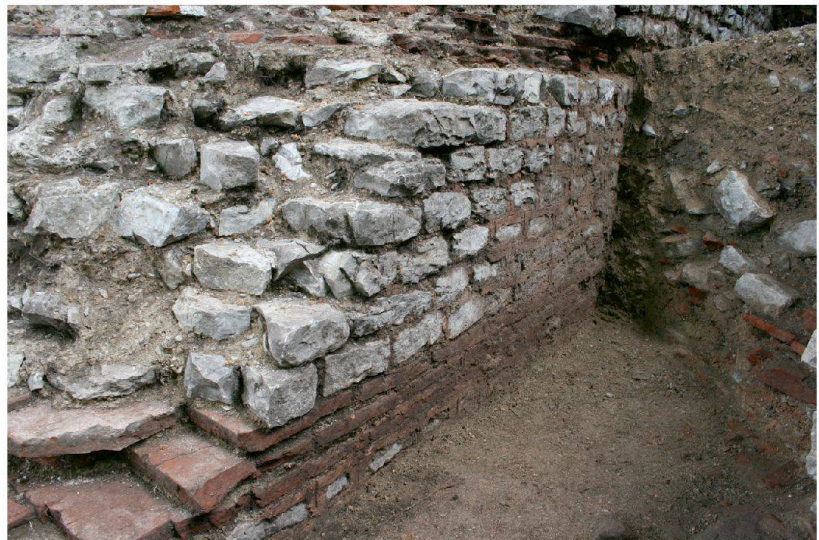
► Abb. 23: Augst BL, Stützpfiler Schönbühl (Grabung 2009.052). Ansicht der westlichen Mauerschale des jüngeren Stützpfilers mit den Ausfugungen mit rötlichem Ziegelmehlmörtel. Von Westen.
