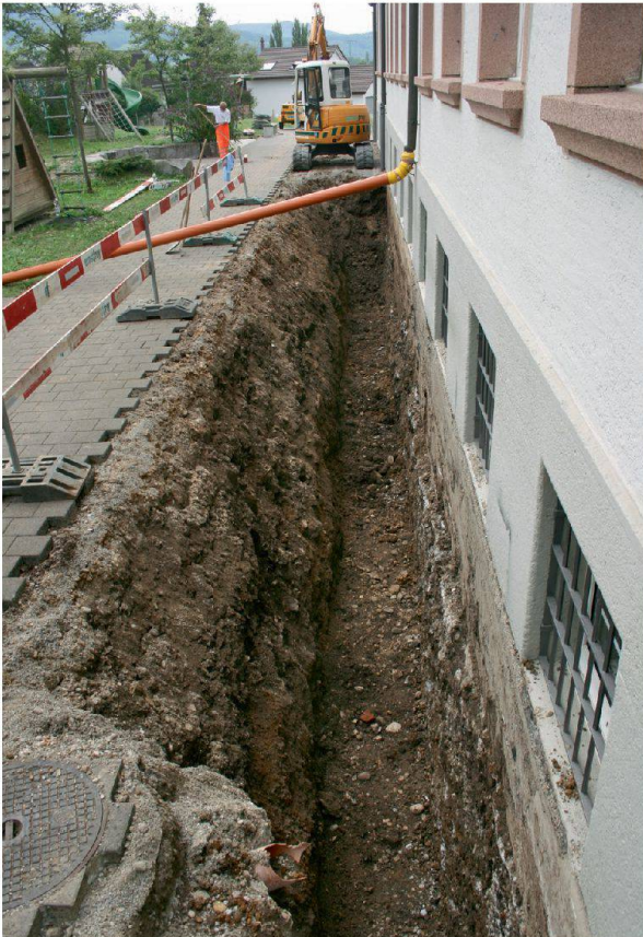
Abb. 55: Augst BL, Schulhaus (Grabung 2009.057). Aushubgraben an der Südseite des Schulhauses. Von Nordosten.
