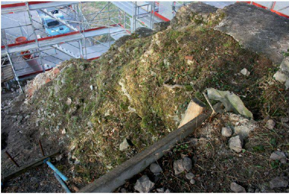
Abb. 18: Augst BL, Stützpfiler Schönbühl (Grabung 2009.052). Zustand des Stützpfilers nach dem Entfernen des Sicherungsnetzes. Von Süden.
