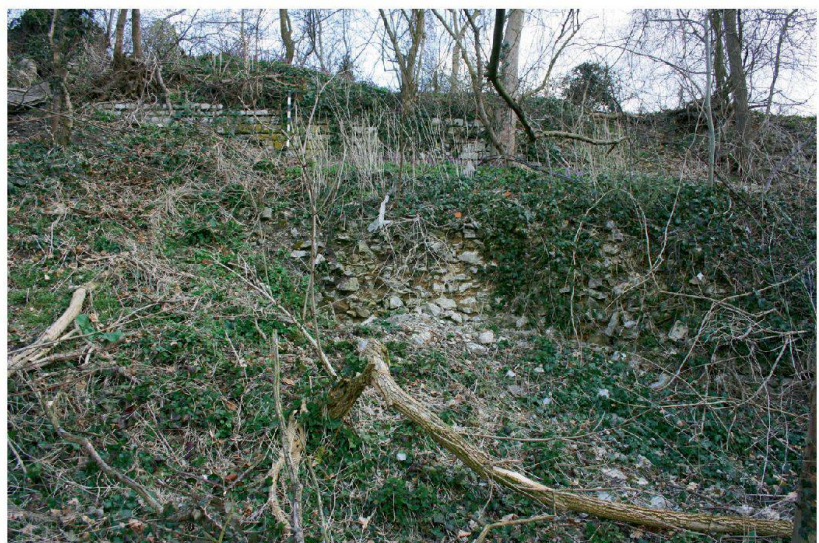
► Abb. 30: Augst BL, Umfassungsmauer Schönbühl (Grabung 2009.053). Blick von Westen an den Abhang des Schönbühls mit den Überresten von römischem Mauerwerk. Der Massstab steht an einer gut erhaltenen Mauer- schale. Beim Mauerwerk in der Bildmitte hat sich die westliche Mauerschale bereits abgelöst.
