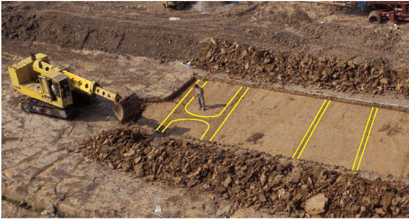
◀ Abb. 40: Kaiseraugst AG, «Im Limer» (Grabung 2000.007). Nur noch als helle Verfärbungen zeichnen sich die Lehmabbaugruben zwischen den dunkleren, stehen gebliebenen Stegen ab. Hier wurde vom 1. bis 4. Jahrhundert sekundär verlagerter Lösslehm in grossem Stil abgebaut.
