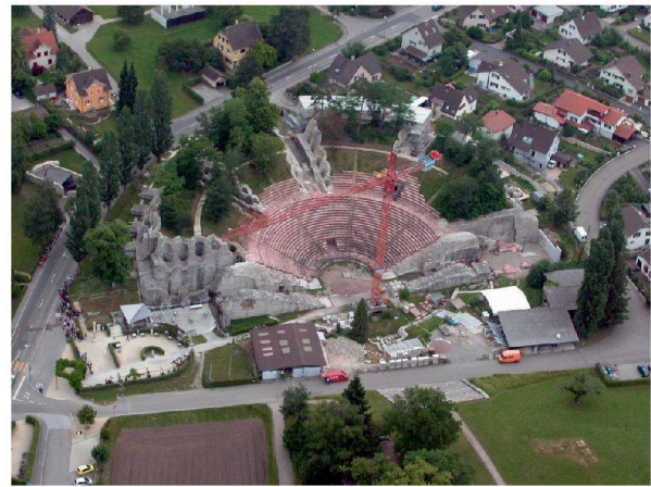
Abb. 31: Augst/BL. Theater während der Sanierung.
