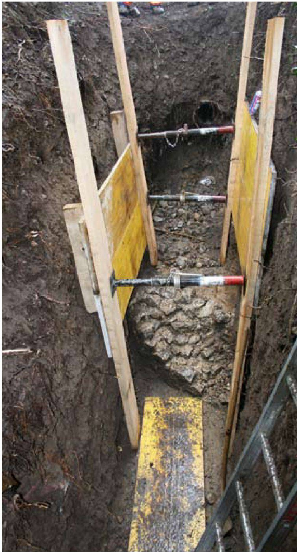
Abb. 36: Augst BL, Obermühle (Grabung 2010.054). Blick von Nordwesten an die im Abhang zur Ergolz zum Vorschein gekommene nördliche Gebäudeaussemmauer MR 4.
