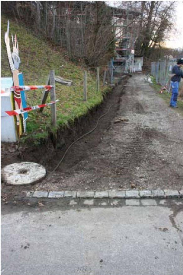
Abb. 3: Augst BL, Vorplatz Brotbackstube (Grabung 2010.051). Blick von Osten in den Weg zur Brotbackstube mit dem bereits ausgehobenen Graben für die Wasserleitung.
