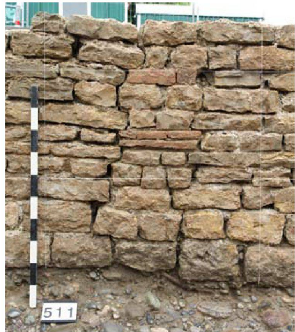
Abb. 19: Kaiseraugst AG, Autoeinstellhalle Löwen (Grabung 2010.001). Nach dem Abklopfen des Verputzes auf MR 30 während der Grabung zeichnete sich die nachträglich eingebaute Mauerpartie deutlich ab. Es ist auch die einzige Stelle, wo Leistenziegel- und suspensura-Fragmente in die Kellerwände eingemauert wurden. Blick von Süden.
