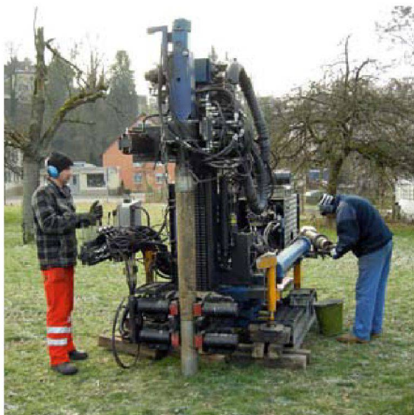
Abb. 39: Kaiseraugst AG, Bohrsondierungen Auf der Wacht (Sondierung 2010.002). Die Maschine im Einsatz während einer Rammkernbohrung.
