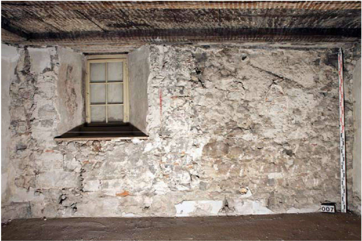
Abb. 51: Kaiseraugst AG, Bauuntersuchung Kirchgasse (Grabung 2010.217). Westfassade Kirchgasse Haus 4, Stube 1. OG.
