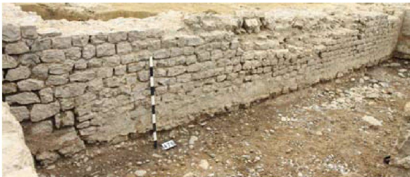
◀ Abb. 17: Kaiseragst AG, Autoeinstellhalle Löwen (Grabung 2010.001). Die südliche Kellermauer (MR 33) ist in einem eher schlechten Erhaltungszustand. Bereits in römischer Zeit hatte sich der Verputz grösstenteils gelöst, während sich die Schalung ein wenig wölbte. Diese Stelle wurde dann auch für das Ausbrechen der behauenen Kalkbruchsteine bevorzugt. Links im Bild sieht man die Unterfangung der Mauer 35 anhand der markanten Baufuge und dank der grösseren, behauenen Kalkbruchsteine. Blick von Nordosten.
