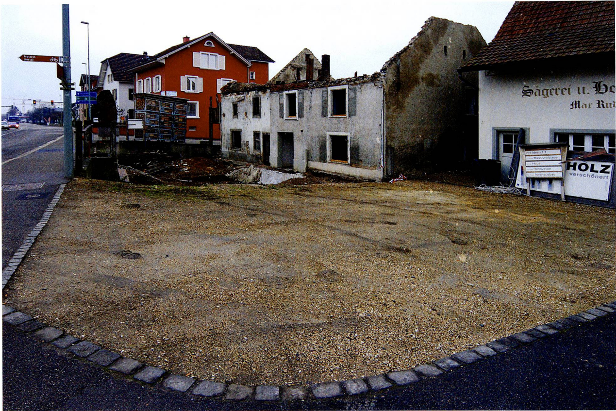
Abb. 17: Augst BL, Sägerei Ruder (Grabung 2011.056). Blick von Osten auf die bereits zum Teil abgebrochenen Liegenschaften Rheinstrasse 2 und 4. Die Zone zwischen den Gebäuden und der Strasse markiert die bereits ausgegrabene Fläche 2010.056.
