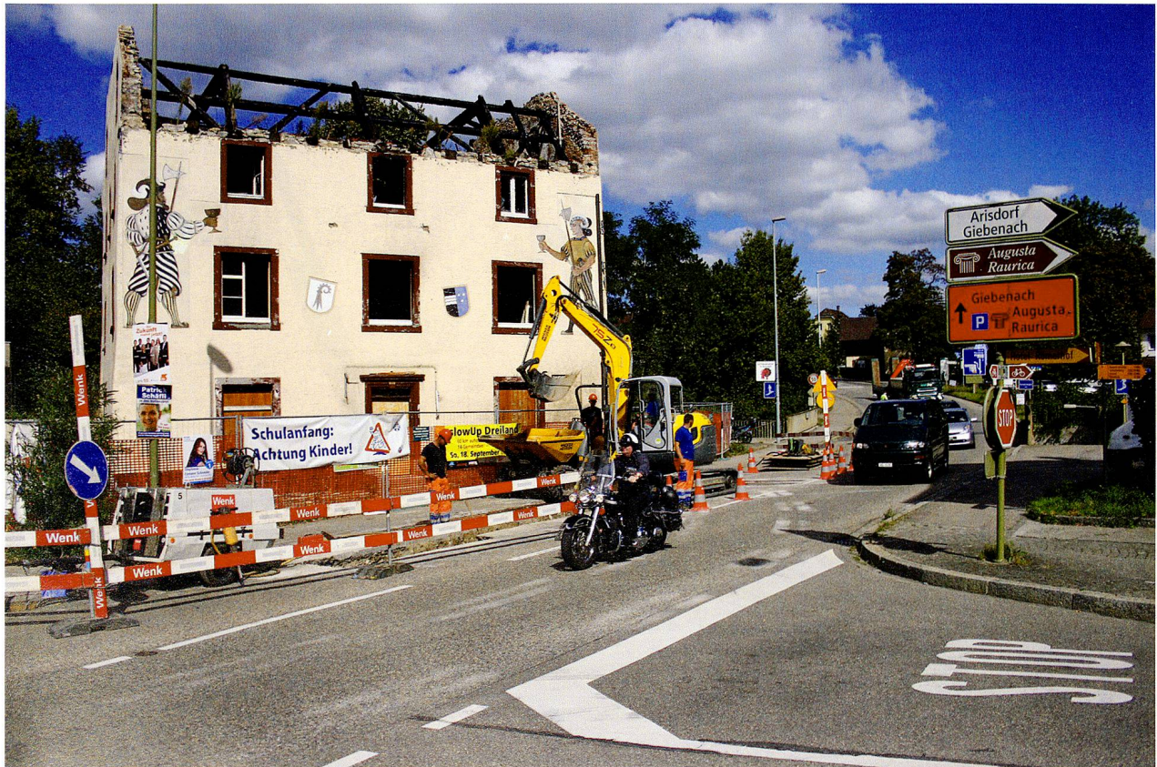
Abb. 32: Augst BL, Swisscom Hauptstrasse (Grabung 2011.062). Situation der Leitungsgrabung bei der Einmündung der Giebenacherstrasse (rechts vorne). Ausgehoben wird gerade der nördliche Grabenteil. Links die bis heute nicht wieder aufgebaute Brandruine des ehemaligen «Moulin Rouge»-Clubs (abgebrannt 2008). Von Südwesten.
