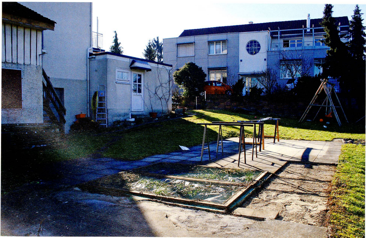
Abb. 4: Augst BL, Blank, Alte Rheinstrasse (Grabung 2011.052). Überblick über den Bauplatz für den Anbau. Links das Haus Blank, rechts hinten das Gebäude, das 1982 zur Ausgrabung «Cito AG» (heute «Baumgartner Sanitär») geführt hat. Im Mittelgrund das gegen links (= Süden) ansteigende Gelände gegen die Alte Rheinstrasse/römische Basiliastrasse. Von Nordnordosten.
