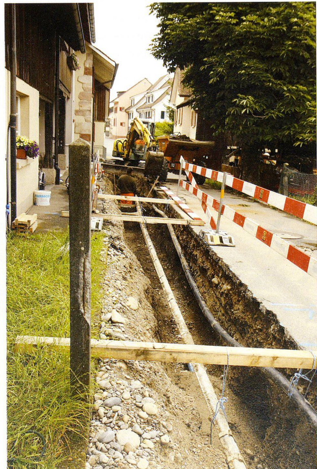
Abb. 55: Kaiseraugst AG, Lindenweg (Baubegleitung 2011.008). Der Lindenweg während der Bauarbeiten. Blick von Osten.
