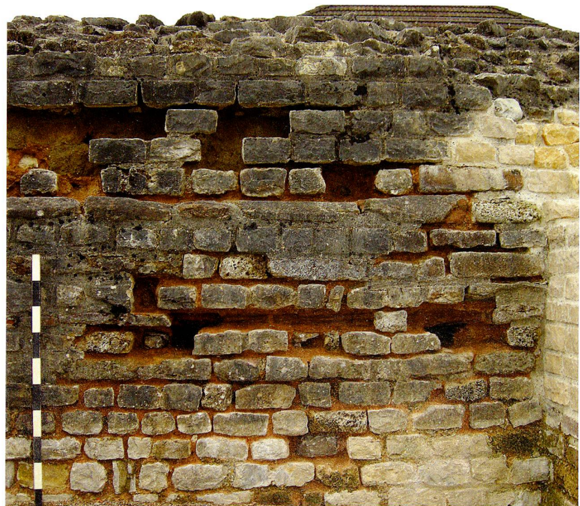
Abb. 51: Kaiseraugst AG, Neugestaltung Dorfplatz (Baubegleitung 2011.002). Blick auf die gereinigte Innenseite der Kastellmauer vor dem neuen Ausfugen zwecks Restaurierung. Dabei sind zwei antike Gerüstlöcher zum Vorschein gekommen. Blick von Norden.
