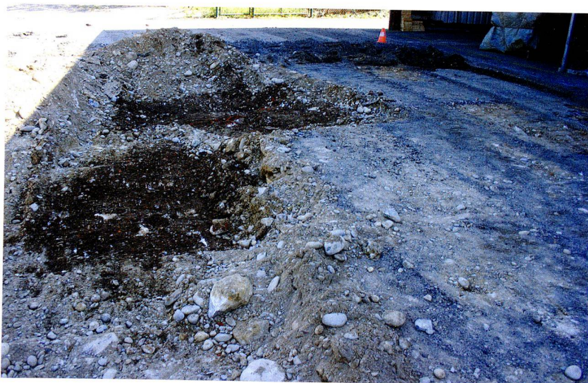
Abb. 29: Augst BL, Werkhof E. Frey AG (Grabung 2012.062). Kein schöner Anblick für Archäologen: die vom Bagger angerissene Zerstörungs-/Schuttschicht über den Gebäuden östlich der antiken Fielenriedstrasse. Von Norden.
