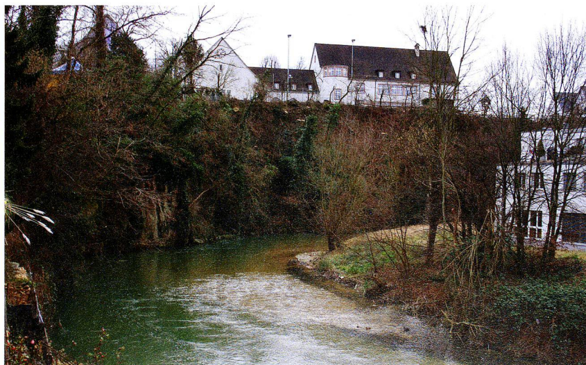
Abb. 32: Augst BL, Ergolzufer (Vorgang 2012.069). Blick von Norden auf den Felshang am Rand der Flur Obermühle. Hinten Mitte das Augster Schulhaus.
