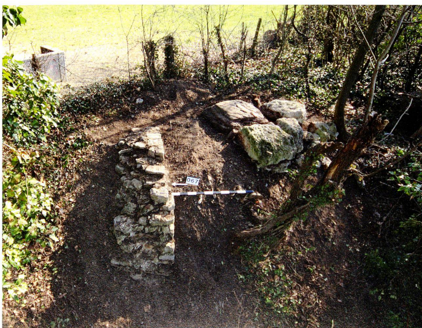
Abb. 17: Augst BL, Schönbühl Umfassungsmauern (Vorgang 2012.054). Links Mauer MR 6, welche zum klassischen Tempelbezirk gehört, mit klaffender Abrisskante. Die Ecke zu MR 4 im Westhang war von Karl Stehlin noch als erhalten eingetragen worden, heute ist sie zum grössten Teil verschwunden. Rechts «Mauer» MR 5, der Rest eines Architekturfragmente-stapels (siehe auch Abb. 22). Von Westen.
