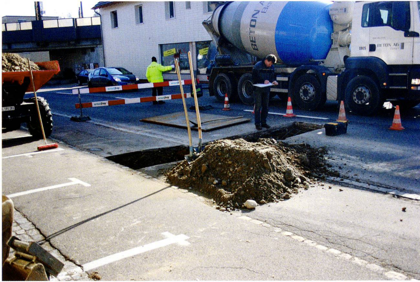
Abb. 7: Augst BL, Hauptstrasse Leitungssondierungen (Grabung 2012.053). Dokumentationsarbeiten an einem prekären Arbeitsplatz. Felder 4 und 5, von Nordwesten.
