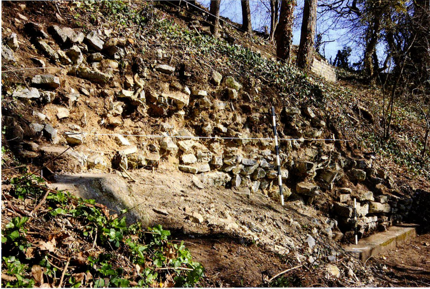
Abb. 18: Augst BL, Schönbühl Umfassungsmauern (Vorgang 2012.054). Mauer MR 2, die äussere Umfassungsmauer des klassischen Tempelbezirks. Links und rechts aussen sind die Betonunterfangungen aus dem Jahre 1941 zu erkennen. Die ursprünglich einmal viel besser erhaltene Mauer wurde damals Teil des Befestigungssystems an der Westseite des Augster Oberstadtplateaus. Erkennbar ist die beträchtliche Dicke der Mauer. Von Nordwesten.
