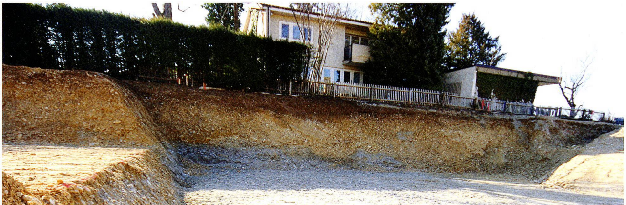
Abb. 4: Augst BL, Hochbordweg (Grabung 2012.051). Westprofil der Baugrube von Südsüdosten.
