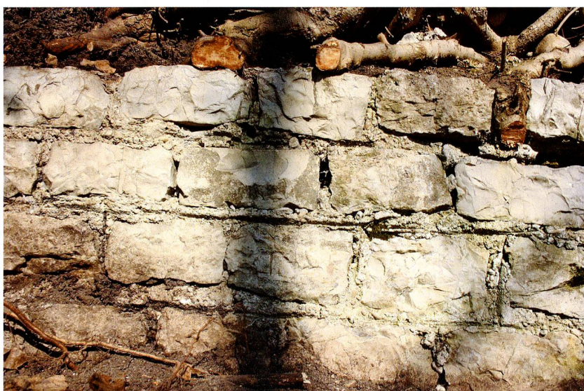
Abb. 16: Augst BL, Schönbühl Umfassungsmauern (Vorgang 2012.054). Sehr gut erhaltene Mauerschale von MR 3 samt Fugenstrich (südlichster sichtbarer Teil; in Abb. 14 liegt die Stelle rechts aussen), welche zum gallo-römischen Tempelbezirk gehört. Die Aufnahme zeigt die Gefährdung des Bauwerks durch Baumwurzeln, welche sich in die Fugen zwischen den Bausteinen drängen und dadurch die Mauern nach und nach aufsprengen. Von Südwesten.
