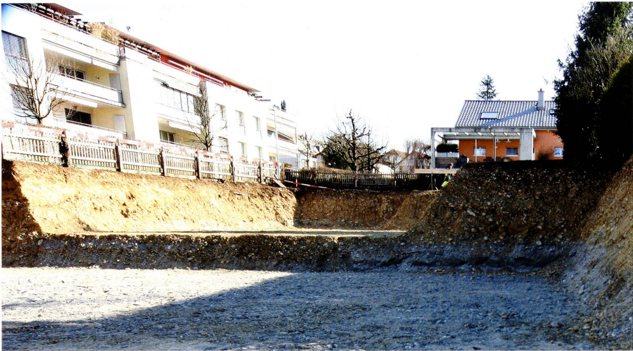
Abb. 5: Augst BL, Hochbordweg (Grabung 2012.051). Südprofile (hinten Mitte und rechts aussen) der Baugrube von Norden.
