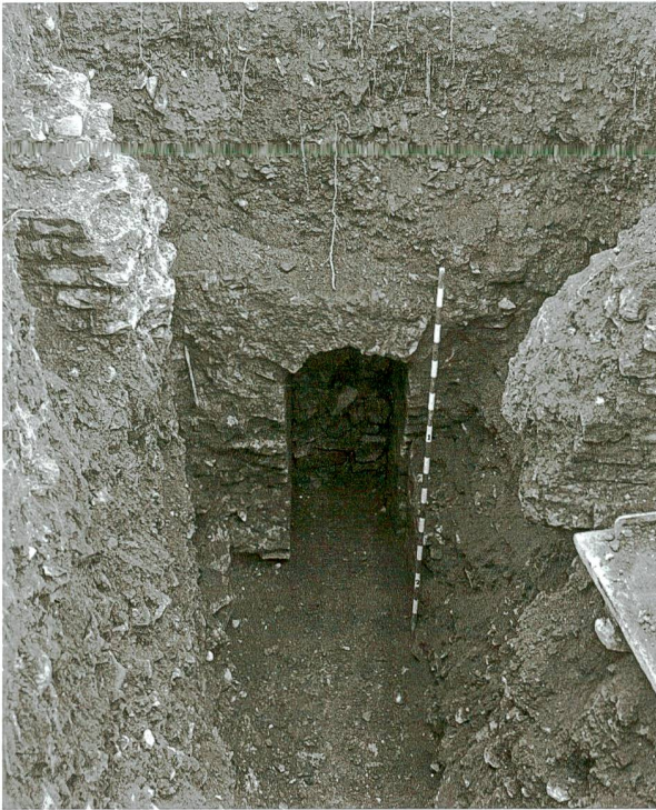
Abb. 31: Augst BL, Zentralthermen (Grabung 1944.051). Blick von Westen an das freigelegte Ende der Kloake.
