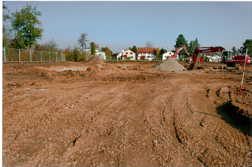
Abb. 55: Augst BL, Gallezen «Rhygarten» (Grabung 2013.068). Aushub im Ostteil der Parzelle. Im Hintergrund die Häuser der bestehenden Überbauung in der Flur Gallezen. Das weisse Gebäude ganz links ist die Trafostation des Kraftwerks Augst-Wyhlen. Von Westen.
