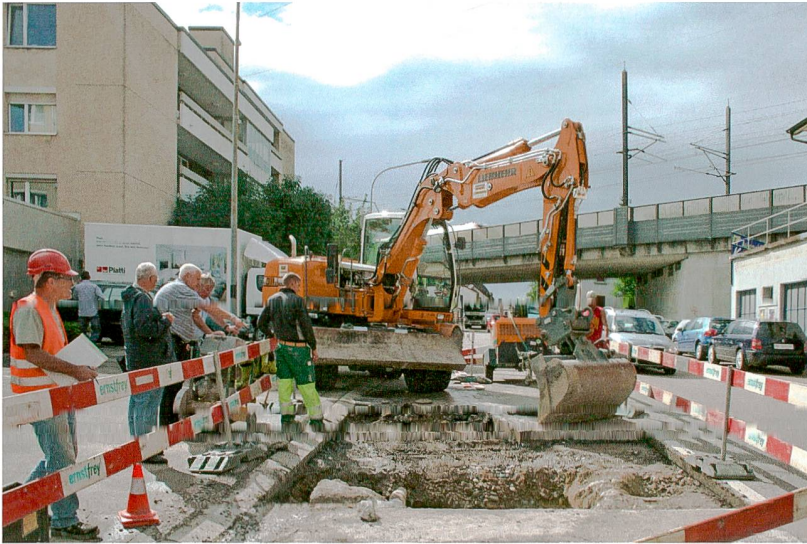
Abb. 51: Augst BL, Hauptstrasse Leitungsbrüche (Grabung 2013.066). Aushubarbeiten auf der Suche nach der Leitung in Feld 3. Von Osten.
