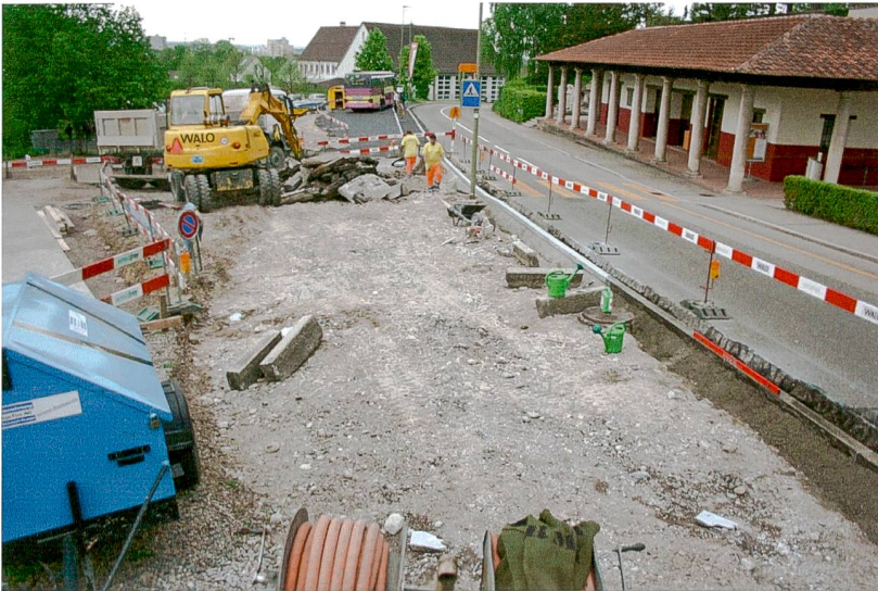
Abb. 12: Augst BL, Theatervorplatz und Archäologisches Zentrum (Grabung 2013.054). Die abgetragene alte Car-Haltestelle im Vordergrund, im Hintergrund (mittig) die neu einggerichtete Car-Haltestelle. Rechts die Portikus des Römerhauses, davor die Giebenacherstrasse. Von Osten.
