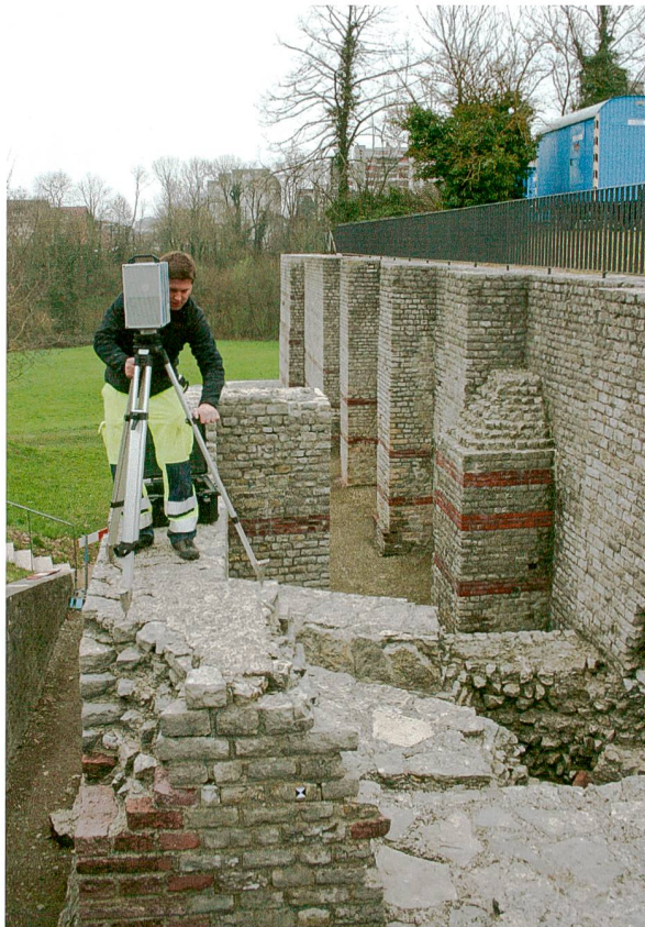
Abb. 13: Augst BL, Laserscan Basilicamauer (Aktенnummer 2013.055). Installation des Laserscangeräts auf einer der Mauern des Monuments. Von Süden.
