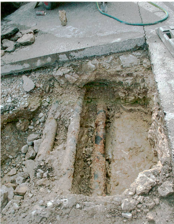
Abb. 52: Augst BL, Hauptstrasse Leitungsbrüche (Grabung 2013.066). In der Nordwestecke von Feld 3, fast in der Mitte der heutigen Strasse, kam die Leitung nach grossflächigem Nachgraben zum Vorschein (tiefstliegende Leitung in Bildmitte). Rechts von der Leitung der anstehende Fels. Von Osten.
