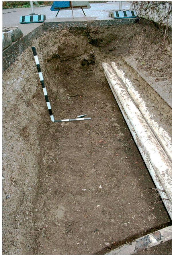
Abb. 57: Augst BL, Kabelgraben Bahnweg–Hauptstrasse (Grabung 2013.069). Die erhaltene Oberfläche der römischen Kultur- oder Brandschicht in Feld 3. Rechts das Rohrbündel der Elektroleitungen. Das Feld liegt an der Ostkante des Hausmattwegs. Von Südosten.
