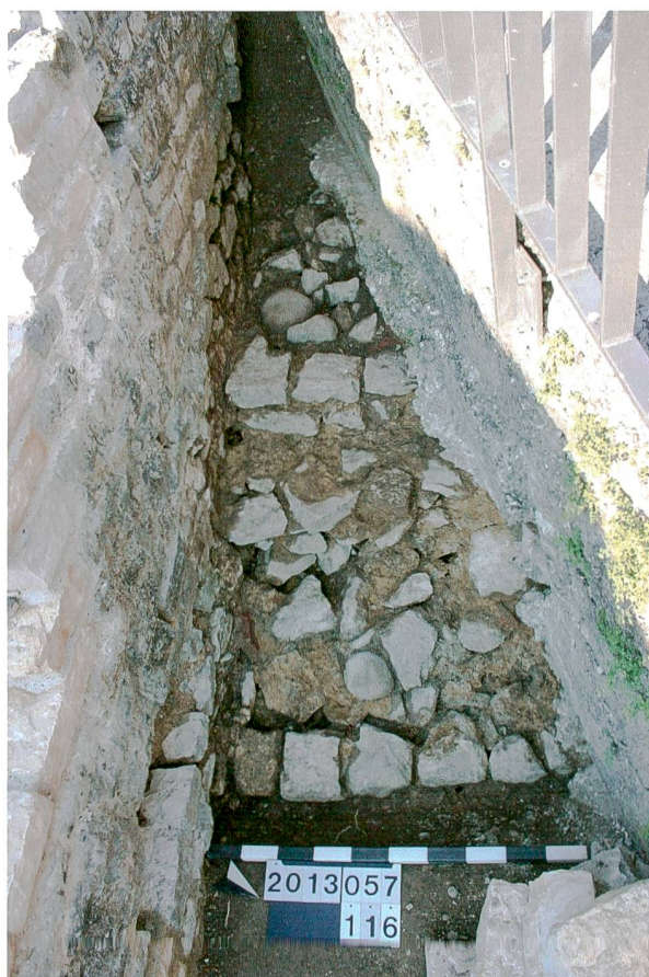
Abb. 22: Augst BL, Stützmauern Basilica (Grabung 2013.057). Untersuchung zu Mauer MR 34, die sich als weitere Treppe erwies. Links im Bild die nordwestliche Aussenmauer des Treppenhauses, rechts die Betonstützmauer des heutigen Weges. Die Partie wurde nach der Dokumentation mit Vlies und einer Kiesschüttung abgedeckt, wird also auch künftig nicht sichtbar sein. Von Nordosten.
