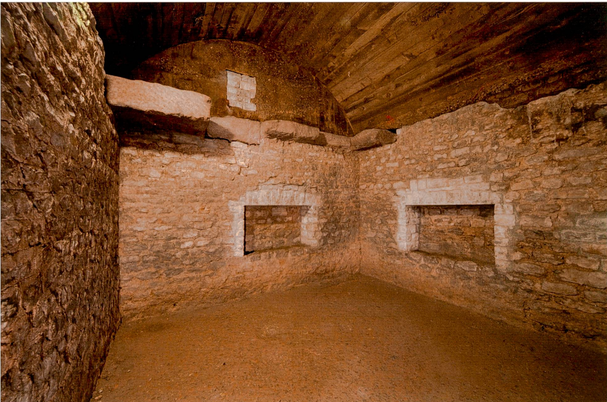
Abb. 29: Augst BL, Vermessung Keller und Kloake (Grabung 2013.061). Blick von Nordosten in den 1943 entdeckten römischen Keller.
