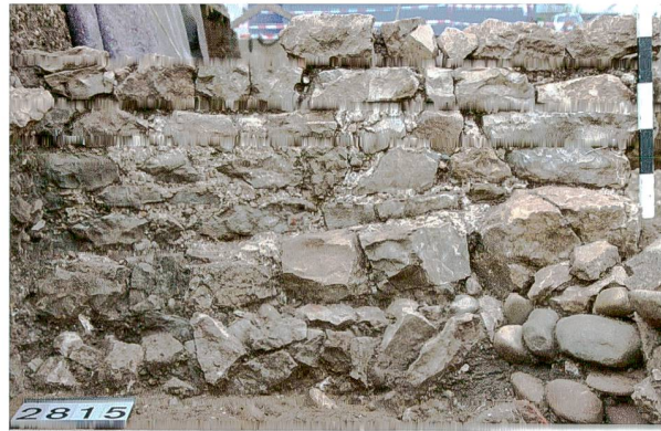
Abb. 26: Kaiseraugst AG, Auf der Wacht (Grabung 2013.001). Ansicht von MR 75. Hier sind Fundament, Ausgleichslage und sechs Lagen aufgehendes Mauerwerk erhalten. Blick von Südosten.
