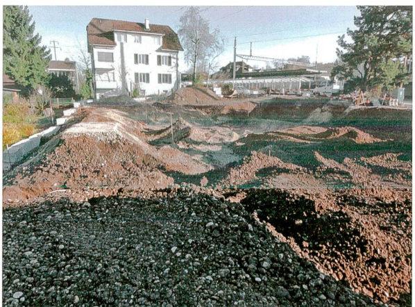
Abb. 68: Kaiseraugst AG, MFH Bahnweg (Baubegleitung 2013.013). Parzelle 106 während der begleiteten Aushubarbeiten. Blick von Westen.
