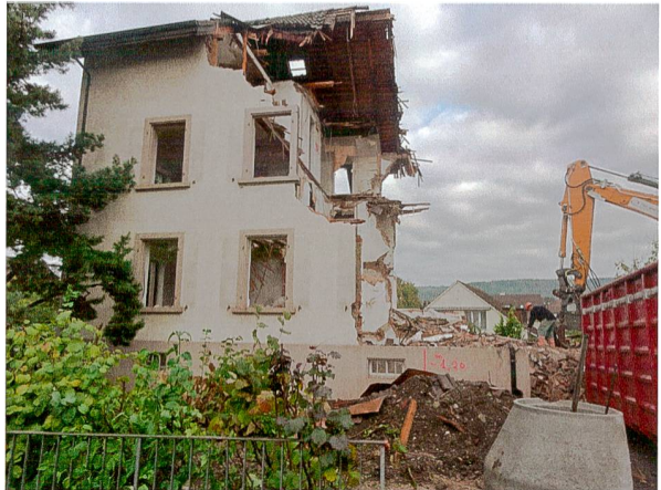
Abb. 67: Kaiseraugst AG, MFH Bahnweg (Baubegleitung 2013.013). Abbruchhaus. Blick von Süden.
