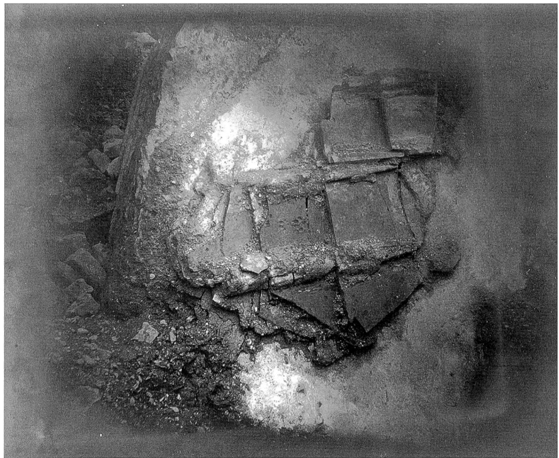
Abb. 24: Augst BL, Heilbad in der Grienmatt (Grabung 1915–1916.062). Aufsicht auf die Oberseite des verstürzten Deckengewölbes mit Resten der erhaltenen Dacheindeckung.
