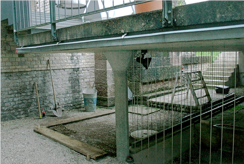
Abb. 37: Augst BL, Theaterfundamente (Grabung 2014.055). Übersicht über das auszuhebende Grabungsfeld. Rechts die Gitterstäbe des «Käfigs» um das Monument Theaterfundamente, oben die Ostkante der Kioskplattform. Die Fläche befindet sich zwischen den Mauern des nördlichen Aditus zum Theater; gegen links geht es zur Orchestra. Von Nordosten.
