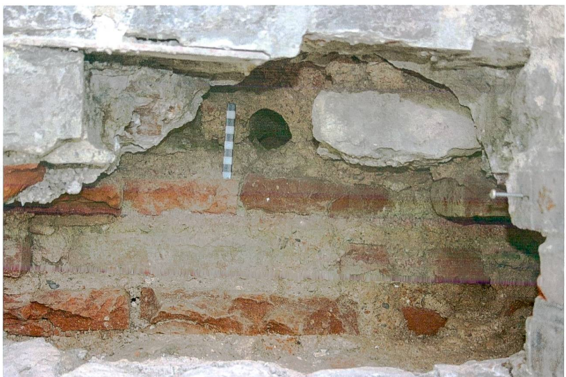
Abb. 58: Augst BL, Stützmauern Basilica (Grabung 2014.057). Nach dem Rückbau der konservierenden Mauerschale von 1941 sichtbar gewordenes originales Gerüstloch in MR 31 (Nordseite). Von Nordwesten.
