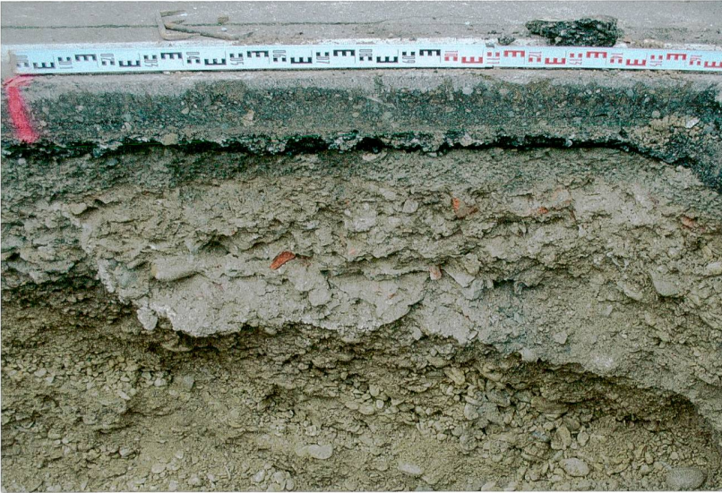
Abb. 25: Augst BL, Wasserleitung Hauptstrasse (Grabung 2014.052). Ausgeräumte Kalksumpfgube im Südprofil des Leitungsgrabens (vgl. Abb. 10,7; 18,7). Der Grubenuriss ist deutlich als schmales weisses Sedimentband erkennbar, die Füllung besteht aus Bauschutt. Von Norden.
