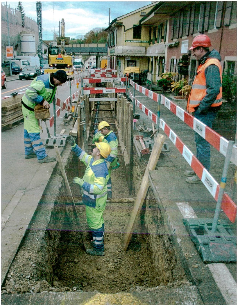
Abb. 24: Augst BL, Wasserleitung Hauptstrasse (Grabung 2014.052). Nach dem Aushub wird sofort gespriesst. Die noch nicht verspriesste Grabenstrecke entspricht der maximalen Länge, die unmittelbar nach dem Aushub wenigstens eine Zeitlang offen blieb, um allfällige Befunde zu dokumentieren. Zum Glück für die beobachtenden Archäologen/-innen (rechts im Bild Freddy von Wyl) musste man sich beim Aushub auf vielen Teilstrecken durch einen dichten Verhau bereits bestehender Leitungen durcharbeiten, was die Aushubgeschwindigkeit doch etwas bremste.
