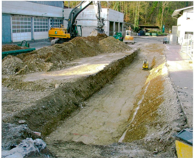
Abb. 32: Augst BL, Werkhof E. Frey AG (Grabung 2015.054). Aushub für das nordwestliche Fundament der geplanten Werkhalle. Von Nordosten.
