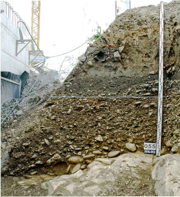
Abb. 28: Augst BL, Hausmatt (Grabung 2015.053). Profil P 29 (Westprofil in Feld 20, vgl. Abb. 27) zeigt eine braune, stark mit Kies durchsetzte Schicht, darunter liegen grössere Rundkiesel. Es handelt sich um Schichten der antiken Hausmattstrasse. Die darüberliegenden Schichten sind moderne Aufschüttungen. Von Osten.
