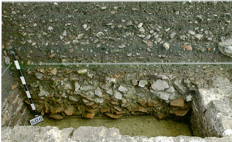
Abb. 37: Kaiseraugst AG, MFH Heidemurweg 28 (Grabung 2015.003). Profil durch den holzbauezeitlichen Halbkeller in Baugrube D: Die Mauerhäupter von MR 17 (links) und MR 13 (rechts) zeigen starke Brandrötungen. Die Verfüllungen bestehen im unteren Bereich aus verbrannten Lehmfachwerkbrocken und Ziegelfragmenten, darüber Mauerzuschutt. Ganz unten ist eine feine Schicht eines verkohlten Holzbodens vorhanden. Im Vordergrund MR 12. Schmurhöhe 270,40 m ü. M. Blick von Osten.
