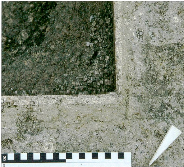
Abb. 19: Kaiseraugst AG, Baugrube Dorfstrasse 29 (Baubegleitung 2015.002). Aufbau der verschiedenen Verputzschichten an MR 72 (unten) und MR 73 (rechts). Blick von Nordwesten.
