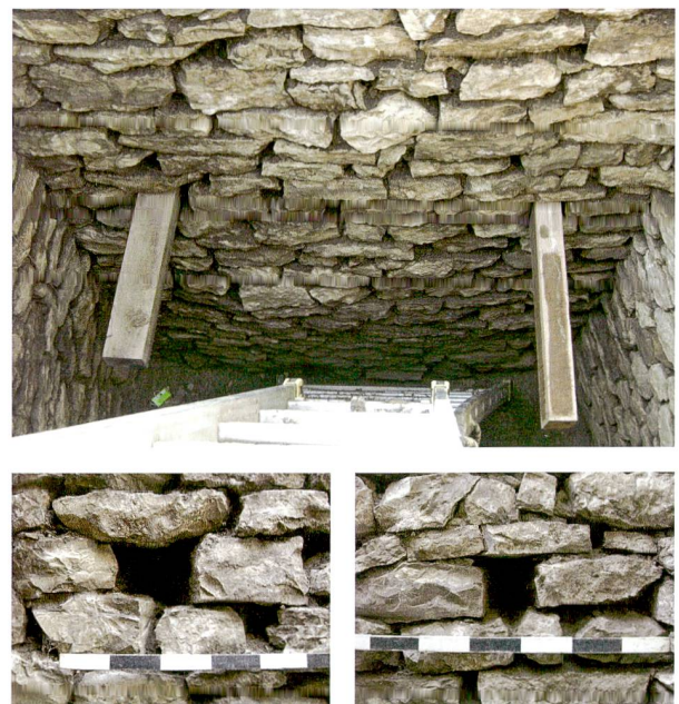
Abb. 8: Kaiseraugst AG, Auf der Wacht (Grabung 2011–2013.001). Schacht MR 6/MR 32 (Zustand im März 2016). Mit modernen Holzbalken markierte Balkennegative in MR 32 und Detailaufnahmen der beiden Balkennegative (vgl. dazu auch Abb. 9).
