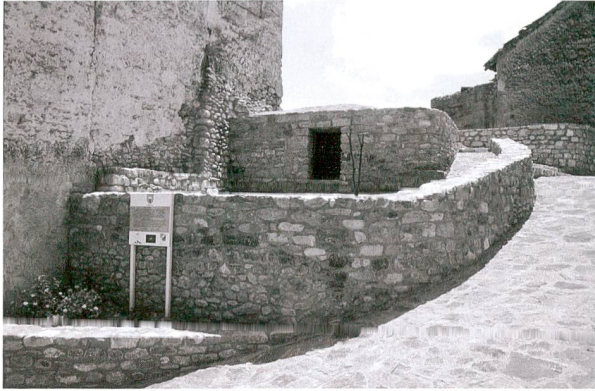
Abb. 14: (Früh-)nezeitliche und moderne Baubefunde, die nachweislich zur Bevorratung von Schnee und Eis dienten. Die frühnezeitliche nevera in Forcall (E) (Zustand nach der Restaurierung im Jahr 1997).
