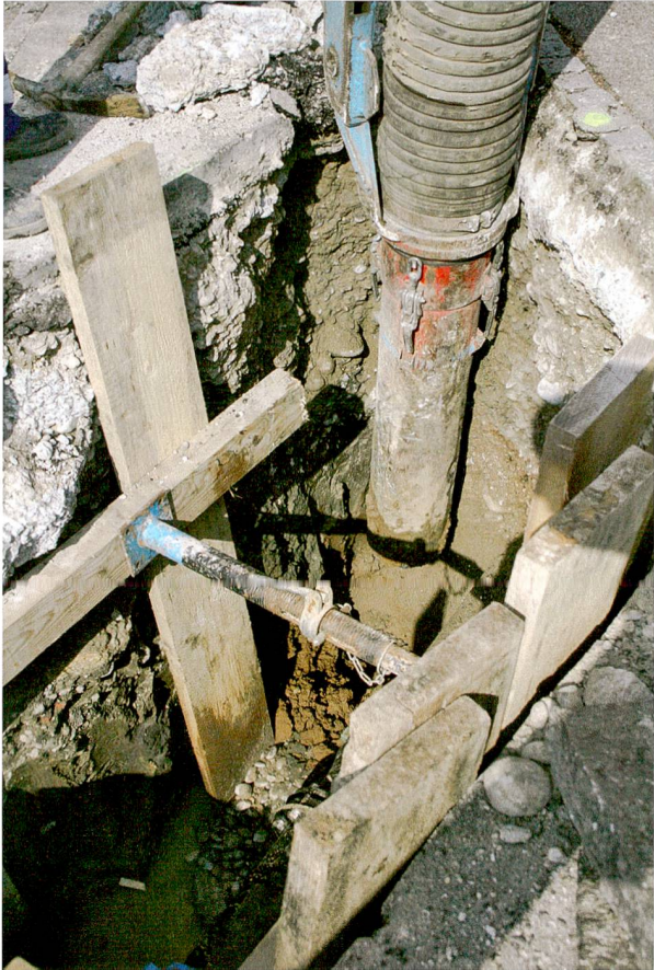
Abb. 88: Pratteln BL, Augsterstrasse (Baubegleitung 2016.068). Auf der Kreuzung von Augster-, Heissgländ- und Wyhlenstrasse zeichnen sich die einzigen Befunde im sonst sterilen Rheinschotter ab: Eine dunkelbraune, kompakte Schicht mit gebrannten Tonbröckchen verläuft von links unten diagonal durch das Bild. In der Bildmitte unter dem Rohr des Saugbaggers ein rotbraunes, sandig-lehmiges Sediment. Datierung und Funktion sind unbekannt.
