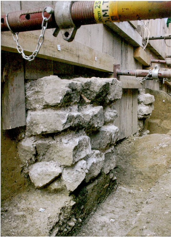
Abb. 44: Augst BL, Rheinstrasse (Grabung 2016.055). Stark von Leitungsgräben gestörtes Fundament aus Kalkbruchsteinen. Das Fundament gehört wohl zu einem Grabmonument. Im beigen Lehm unter dem Fundament zeichnen sich dunkelbraun die Reste einer Unterlage aus Rundhölzern ab.
