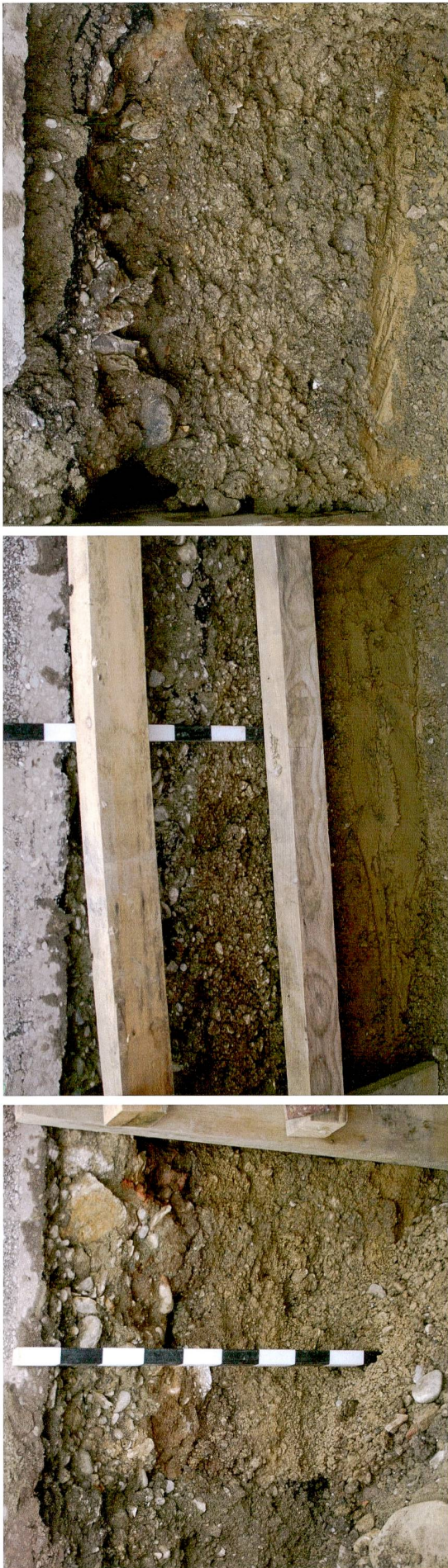
Abb. 15: Augst BL, Rheinstrasse (Grabung 2016.055). Kieskofferungen im Leitungsgabenprofil südlich der Rheinstrasse. Wohl Randbereich der römischen Strasse. Links: P 64 Ost; Mitte: P 64 West; rechts: P 65. Lage der Profile vgl. Abb. 10.
