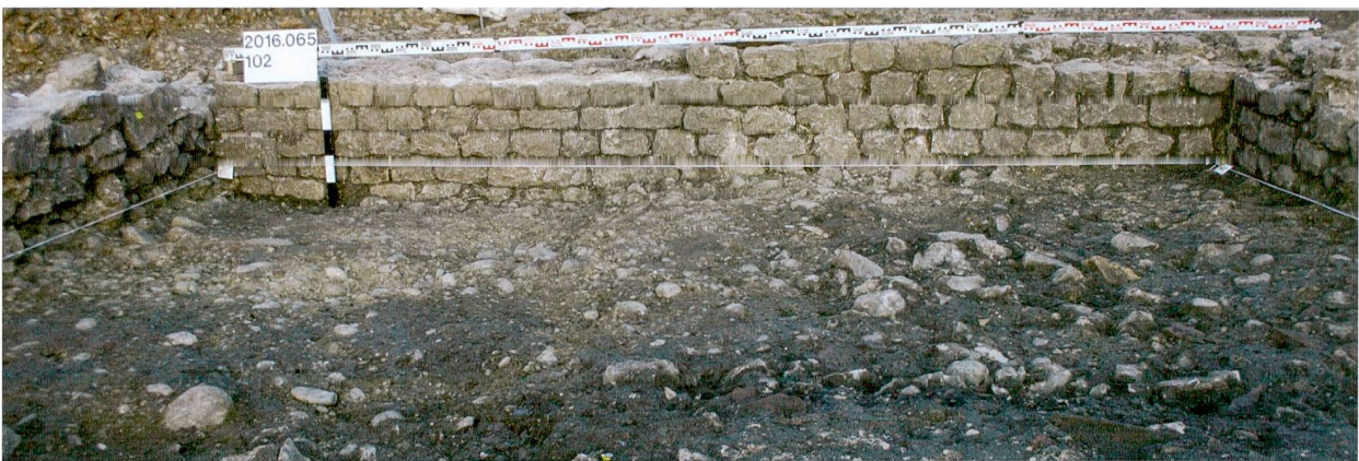
Abb. 72: Augst BL, EFH Sichelstrasse (Grabung 2016.065). Ansicht des Südwesthaupts von Mauer MR 1. Deutlich ist das sorgfältig gebaute Mauerwerk zu erkennen, im Gegensatz zu demjenigen von Mauer MR 2 links im Bild. Schnurhöhe 285,25 m ü. M. Blick von Südwesten.
