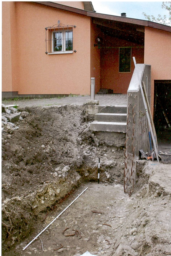
Abb. 64: Augst BL, Schufenholzweg 12 Hauszugang (Augenschein 2016.063). Blick von Nordosten auf die Baugrube. Die Schichten beim Doppelmeter und beim Massstabsbalken könnten noch intakt sein.
