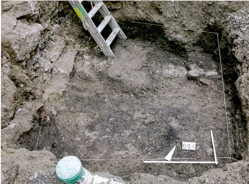
Abb. 28: Kaiseraugst AG, Umbau MFH Dorfstrasse 41/43 (Grabung 2016.003): Baugrube für den zukünftigen Liftschacht. Oben rechts die spärlichen Reste von Mauer MR 8. Blick von Südosten.
