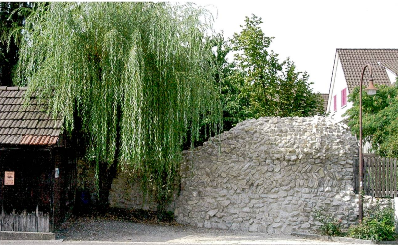
Abb. 58: Kaiseraugst AG, Sanierung Geräteschuppen Heidemurweg (Baubegleitung 2016. 008). Situation im Jahr 2003 direkt nach der Restaurierung. Der Originalmauer kern ist nun mit einer neu aufgemauerten Schale geschützt. Blick von Süden.
