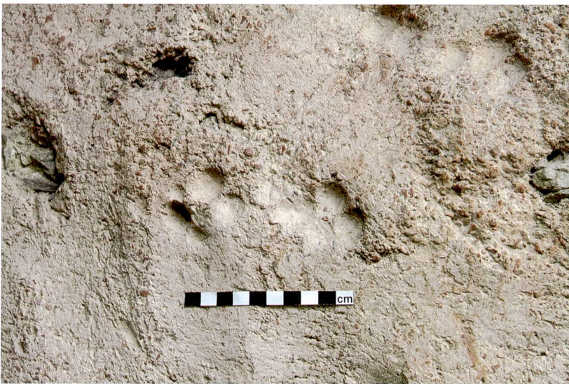
Abb. 40: Kaiseraugst AG, Nachuntersuchungen Schmidmatt (Dokumentation 2016.005). Haus 2, Raum 10: Detail von Mauer MR 27 mit Fingerabdrücken im Grobverputz. Blick von Süden.
