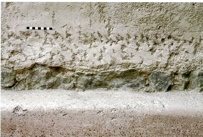
Abb. 41: Kaiseraugst AG, Nachuntersuchungen Schmidmatt (Dokumentation 2016.005). Haus 2, Raum 10: Detail von Mauer MR 29 mit gepickter Putzoberfläche oberhalb des Beckens MR 74. Blick von Westen.
