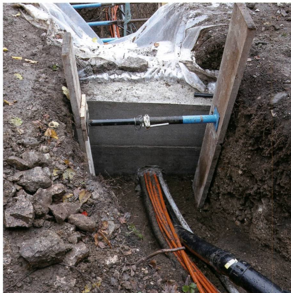
Abb. 49: Augst BL, Kanalisation Tierpark (Baubegleitung 2017.064). Innenseite der Stadtmauer mit angegossener temporärer Betonstützmauer zur Verankerung der Kernbohrmaschine. Blick von Westen.
