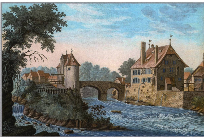
Abb. 25: Augst BL, Hauptstrasse 33 (Baubegleitung 2017.061). Blick von Norden: Die alte Ergolzbrücke mit dem Tor und der Gartenanlage im Bereich des nachmaligen Polizeipostens. Originalbeschriftung: «Basel-Augst von Mitternacht anzusehen». A. Ergolz. B. Violenbach. Emanuel Büchel, 1754.
