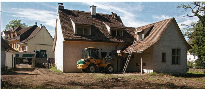
Abb. 22: Augst BL, Hauptstrasse 33 (Baubegleitung 2017.061). Der ehemalige Polizeiposten kurz vor dem Abriss. Blick von Norden.
