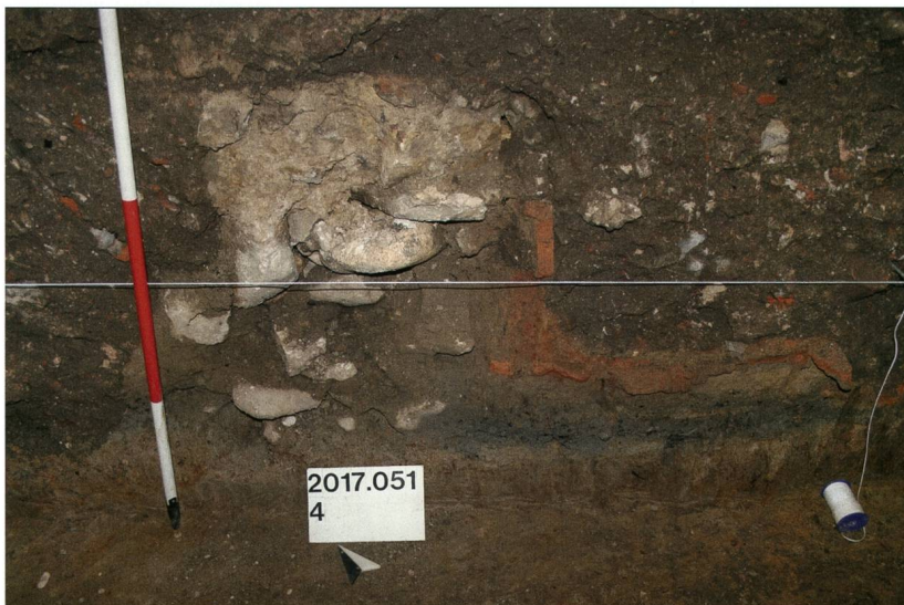
Abb. 4: Augst BL, Minervastrasse 4 Solarwassertank (Baubegleitung 2017.051). Teil von Nordostprofil P 2 (siehe Abb. 3). MR 1 mit Fundament und einhäutigem aufgehendem Mauerwerk. Rechts davon die ziegelverkleidete Wanne, die während der Grabung von 1959 geschnitten und geleert wurde. Darunter sind Reste von holzbauzeitlichen Schichten zu sehen. Blick von Südwesten.
