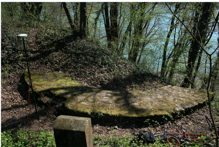
Abb. 18: Wyhlen (D), römischer Brückenkopf (2017.005). Die konservierten Reste des östlichen Turms von Nordwesten.
