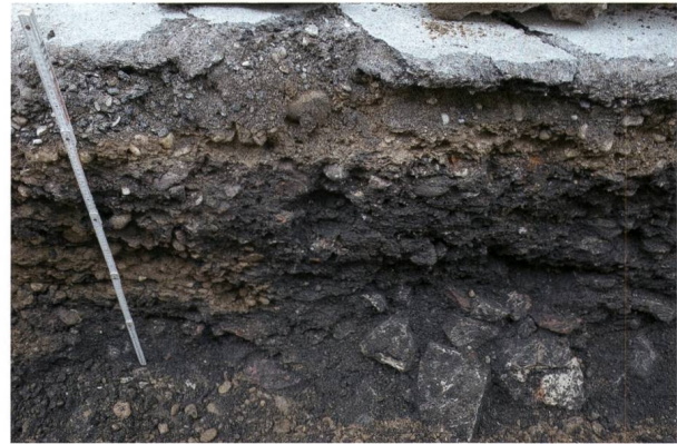
Abb. 15: Kaiseraugst AG, Gasleitung Tränkasse (Begleitung 2017.004). Blick von Osten auf die westliche Leitungsgrabenwandung mit dunklen schutthaltigen Schichten.
