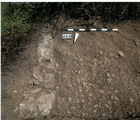
Abb. 4: Kaiseraugst AG, Landstrasse (Grabung 2017.001). Aufschluss in der westlichen Baumgrube bei der Schmidmatt. Blick von Norden auf die Abbruchkrone von Mauer MR 35 und den anschließenden Kiesbelag.
