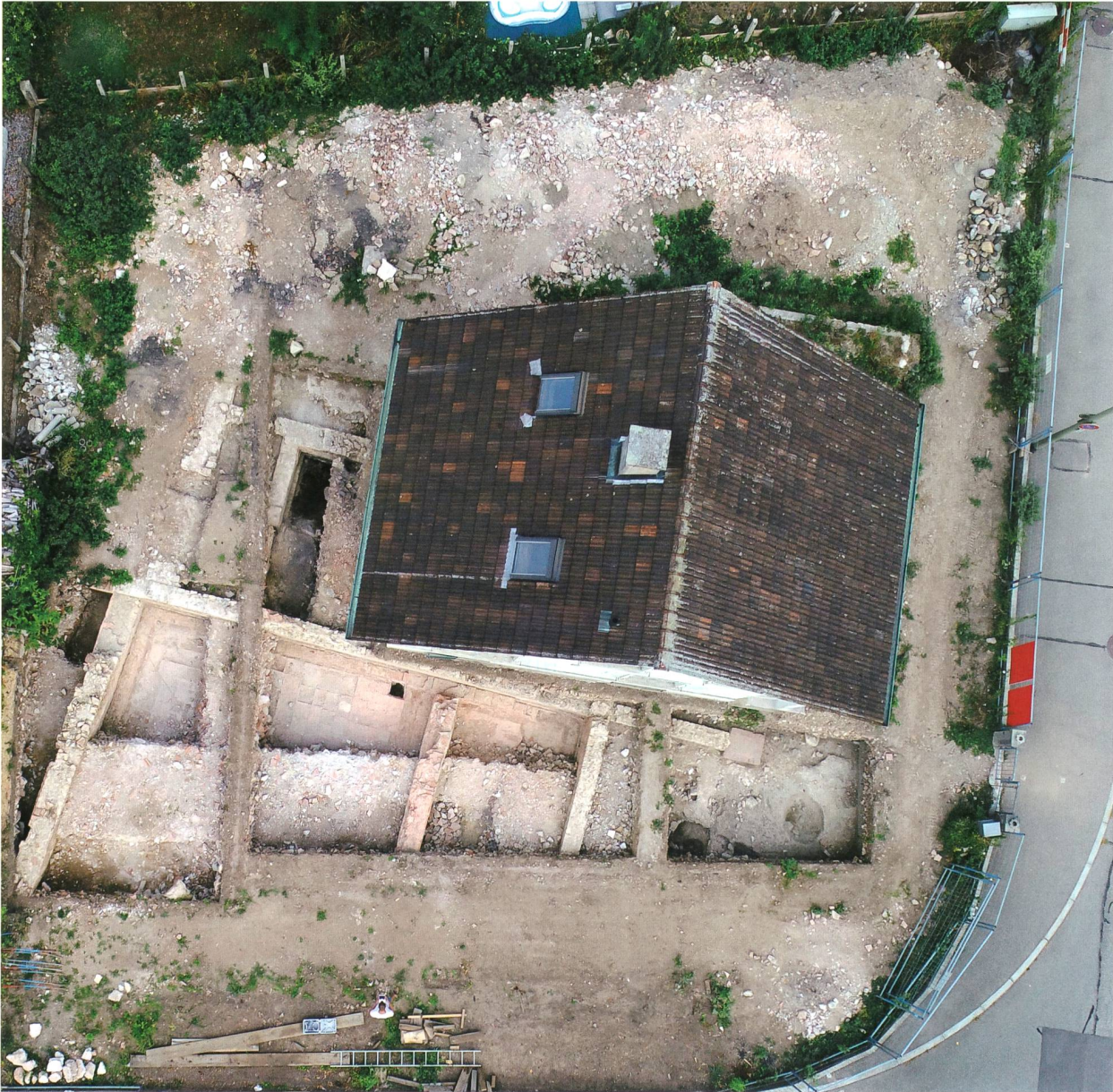
Abb. 10: Augst BL, Anbauten Giebenacherstrasse 26 (Grabung 2018.055). Drohnenaufnahme nach Grabungsende. Norden ist oben rechts.
