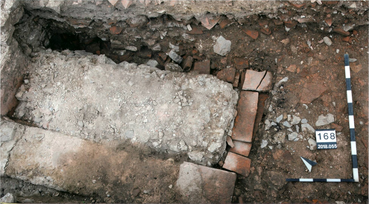
Abb. 29: Augst BL, Anbauten Giebenacherstrasse 26 (Grabung 2018.055). In die Grob- schuttplanie eingetieft Struktur in der Raumecke MR 11/MR 13. Die ver- witterte mörtelgussbodenähnliche Fläche ist mit Ziegelplattenfragmenten umrandet. Blick von Südwesten.
