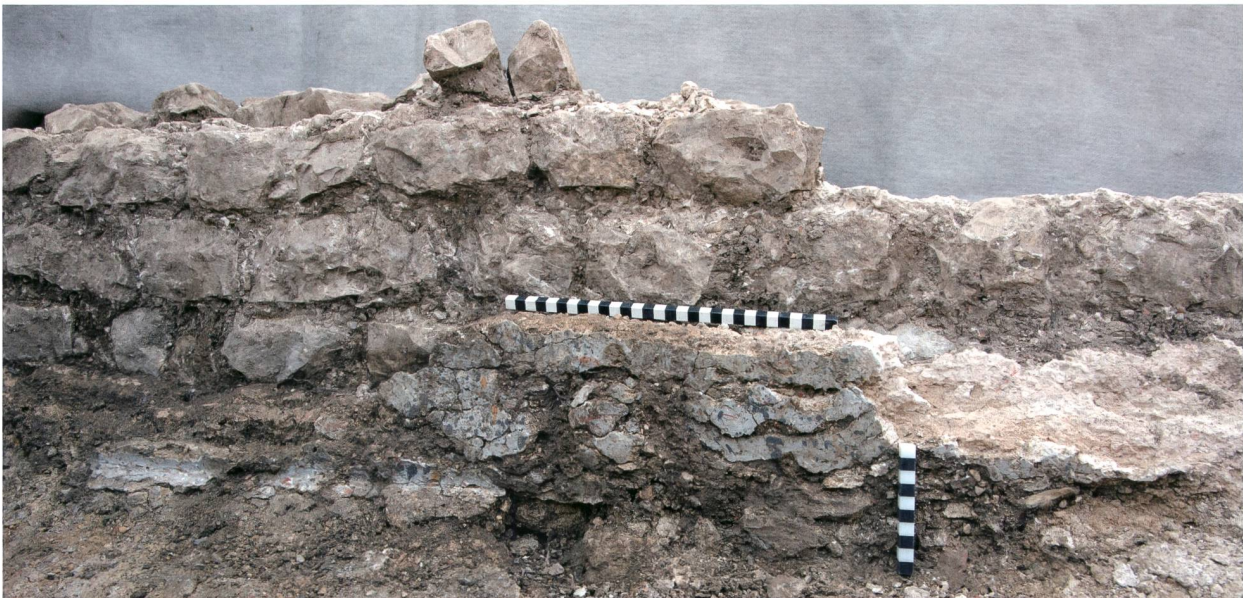
Abb. 25: Augst BL, Anbauten Giebenacherstrasse 26 (Grabung 2018.055). Blick von Nordwesten auf die in-situ-Reste einer gemalten Marmorimitation in der Sockelzone der Nordwestwand von Mauer MR 1 bei der Südecke von Raum 6.
