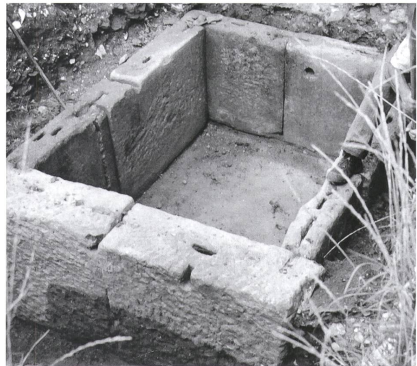
Abb. 24: Augusta Raurica. Laufbrunnen 7b an der Ostrandstrasse (Grabung 1971.053, vgl. Abb. 23,7b; 25,7b) vor der Bergung. Blick von Süden. Bezeichnungen der Laufbrunnen nach Furger 1997.
