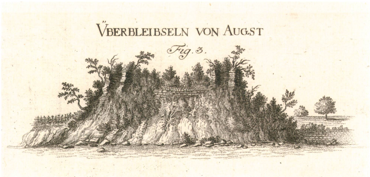
Abb. 7: Unter dem Titel «Überbleibseln von Augst» ist die älteste von Emanuel Büchel gezeichnete Ansicht der römischen Mauern am südlichen Ufer der Insel Gwerd in Daniel Bruckners Versuch einer Beschreibung historischer und natürlicher Merkwürdigkeiten der Landschaft Basel von 1763 publiziert. Die U-förmigen Mauern stehen auf einem Hügel, der sich um einiges über das umgebende Terrain der Insel erhebt. Blick nach Norden. Ohne Massstab.
