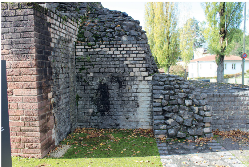
Abb. 24: Augst BL, Theater (Monumentenrestaurierung 924.2019.01). Nordseite beim Eingang zum Nordost-Vomitorium. Reinigungsversuche mit Heissdampf: Zustand vor der Reinigung.
