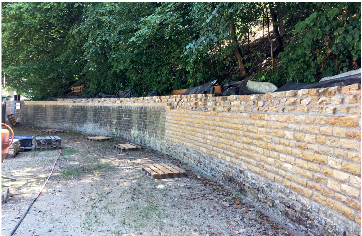
Abb. 10: Augst BL, Amphitheater (Monumentenrestaurierung 905.2019.01). Restaurierung und Erneuerung der rekonstruierten Podiumsmauer. Der noch unpatinierte Südostabschnitt der Podiumsmauer nach Beendigung der Arbeiten.
