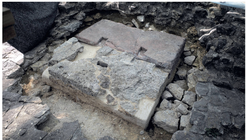
Abb. 4: Augst BL, Schönbühl (Monumentenrestaurierung 903.2019.01). Konservierung eines originalen Stereobatenquaders des Schönbühltempels. Das fertig konservierte und partiell ergänzte Quaderfundament, bestehend aus einem antiken Kalkstein- und einem 1957-59 ergänzten Sandsteinquader.
