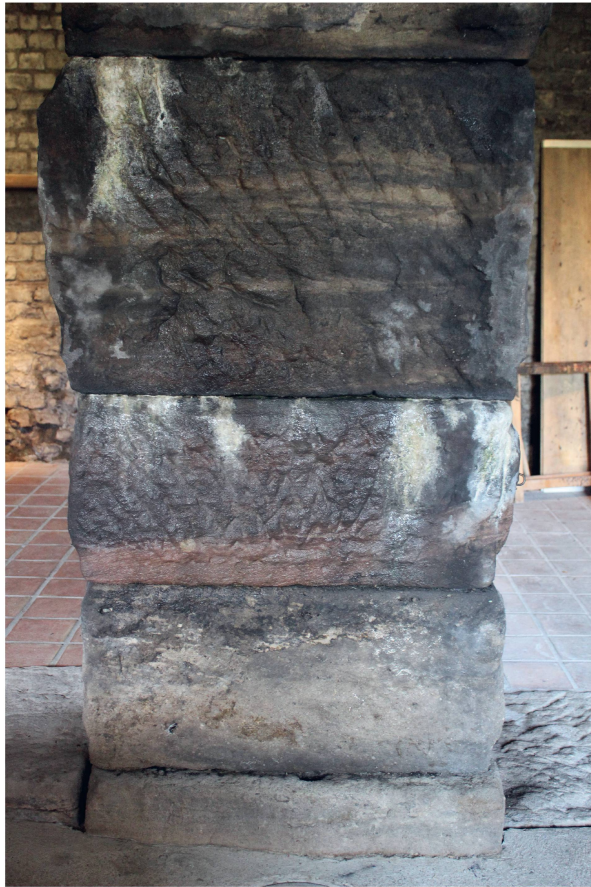
Abb. 6: Augst BL, Schönbühl (Monumentenrestaurierung 903.2019.02). Reinigungstests in der Brotbackstube am Mauerwerk der Stützmauerkonstruktion. Situation vor (links) und nach (rechts) dem Anlegen von Testflächen. Sandsteinabschluss desselben Mauerteils. Während auch hier die Sinterspuren verschwunden sind, ist der Reinigungseffekt in den Zonen mit Algenbildung eher gering.
