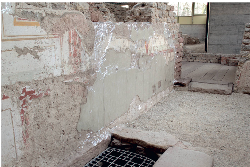
Abb. 20: Kaiseraugst AG, Schmidmatt (Monumentenrestaurierung 917.2019.01). Wandmalerei in Korridor 5. Ethanolkompressen als Vorbereitung zum Entfernen des in den 1980er-Jahren angebrachten synthetischen Plextolmörtels.
