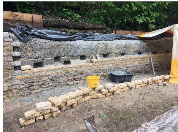
Abb. 7: Augst BL, Amphitheater (Monumentenrestaurierung 905.2019.01). Restaurierung und Erneuerung der rekonstruierten Podiumsmauer. Links: Abgebrochene rekonstruierte Mauerschale, dahinter kommt der Betonkern der Rekonstruktion zum Vorschein, der stellenweise extrem porös und wasserdurchlässig ist. Rechts: Beginn der Aufmauerung der neuen Natursteinschale, zur besseren Verbindung wurden Löcher in den Betonkern gespitzt, die als Aufnahme für Binder-Quader fungieren.
