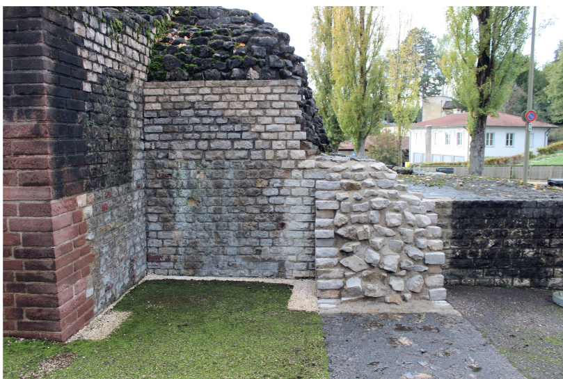
Abb. 25: Augst BL, Theater (Monumentenrestaurierung 924.2019.01). Nordseite beim Eingang zum Nordost-Vomitorium. Reinigungsversuche mit Heissdampf: Zustand nach der Reinigung.
