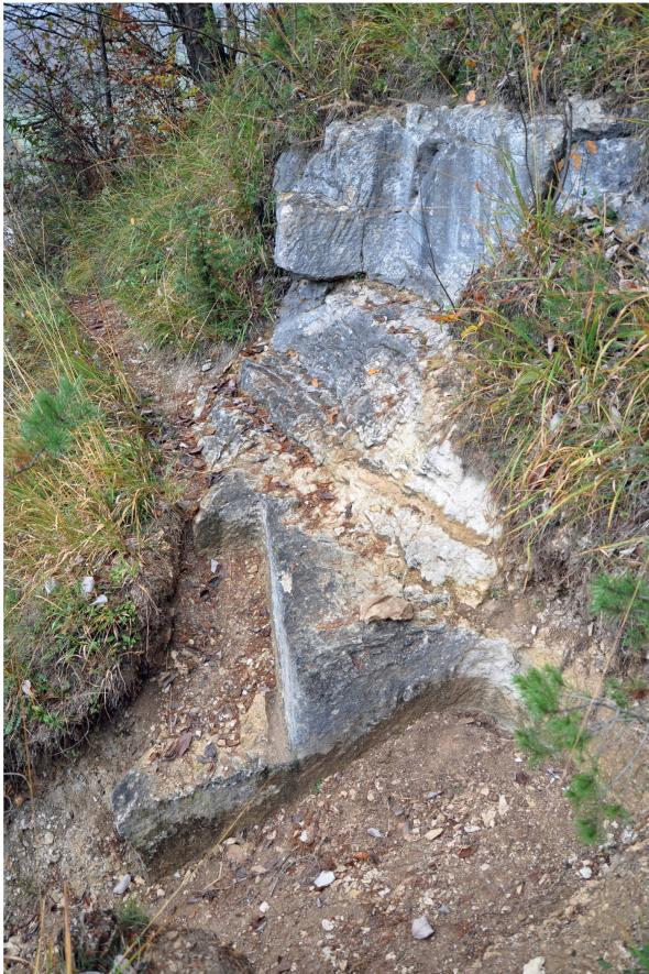
Abb. 13: Dittingen BL, Flur Rittenberghollen. Abbauspuren in Form von Schrotgräben und Negativen von Blöcken im Korallenkalk der St.-Ursanne-Formation. Zustand im Oktober 2012.
