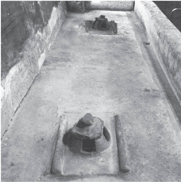
Abb. 35: Pompeji (I), Casa del Centenario (IX 8, 3.6). Zwei Lüftungsziegel auf der Decke der Kryptoportikus.
