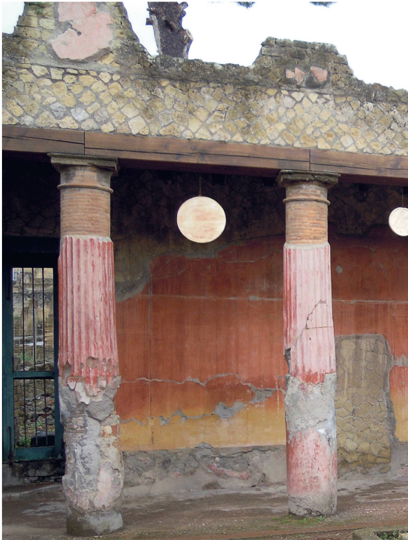
Abb. 31: Herculaneum (I), Casa del Rilievo di Telefo. Stuckierte Ziegelsäulen im Atrium.
