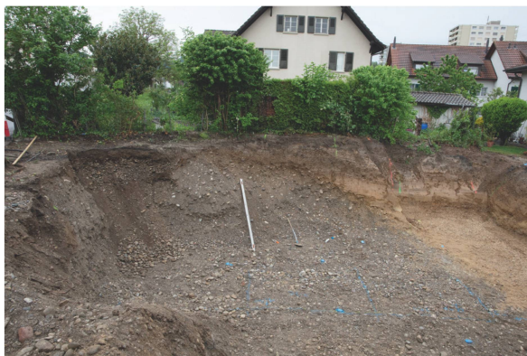
Abb. 7: Pratteln BL, Neubau Augsterheglistrasse 1 (Baubegleitung 2020.053). Blick von Nordosten in die Baugrube des zukünftigen Mehrfamilienhauses. In der Bildmitte die hochaufstossende geologische Kiesrippe; links davon ist das Terrain gestört.
