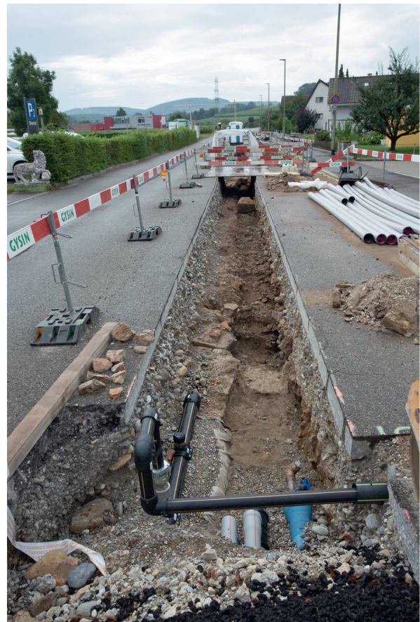
Abb. 9: Augst BL, Wasserringschluss Giebenacherstrasse (Grabung 2020.054). Blick von Nordwesten in den Leitungsgraben bei Grabungsende: links der höher gelegene Bereich für die Gasleitung, rechts derjenige für die Wasserleitung nach dem Handabtrag durch einen Teil der römischen Kulturschichten.
