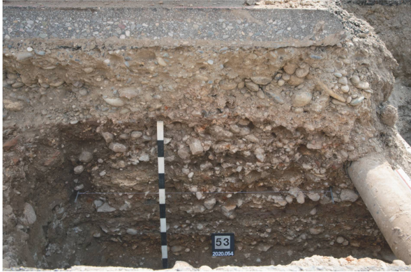
Abb. 11: Augst BL, Wasserringschluss Giebenacherstrasse (Grabung 2020.054). Nordwestprofil P 3: Strassenkörper mit den horizontalen, übereinanderliegenden Strassenbelägen der Merkurstrasse. Schnurhöhe 294,60 m ü. M.
