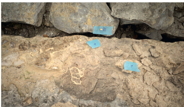
Abb. 6: Augst BL, Schönbühl (Monumentenrestaurierung 903.2020.02). Restaurierung der Stereobatenquader und der SE-Ecke des Tempelpodiums. Südliches in situ erhaltenes Quaderfundament: Im Rahmen der Restaurierungsarbeiten wurden die noch vorhandenen abgeplatzten Stücke mit Kalk wieder zurückgeklebt und offene Fugen und Lager mittels Kalkinjektionen gesichert.
