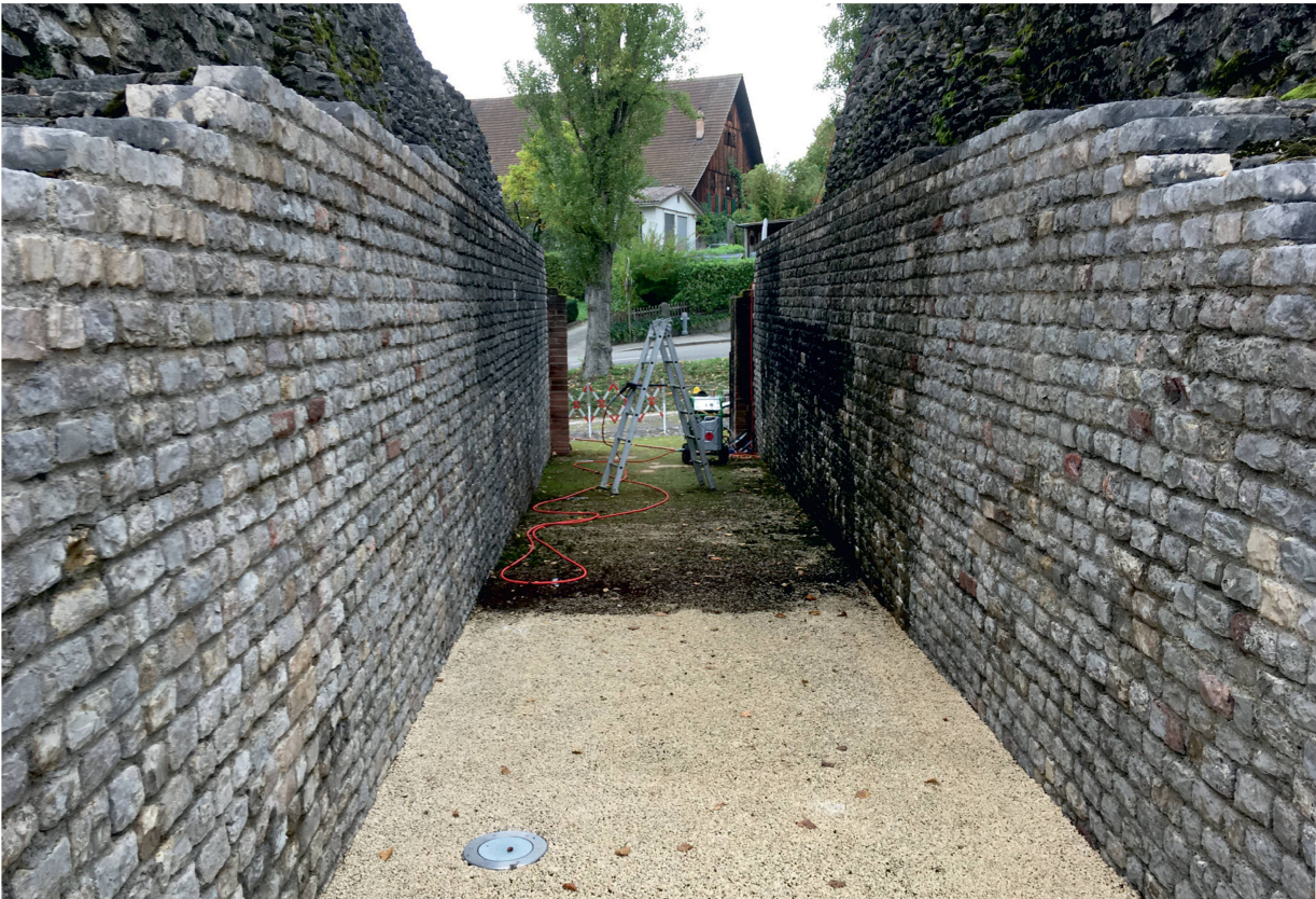
Abb. 41: Augst BL, Theater (Monumentenrestaurierung 924.2020.02). Umfassende Reinigungsarbeiten in den vomitoria und den aditus. Blick von Süden in das Nordost-Vomitorium während der Reinigungsarbeiten. Der Effekt der Massnahmen ist deutlich sichtbar.
