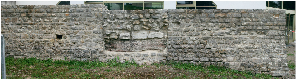
Abb. 33: Kaiseraugst AG, Gewerbehaus Schmidmatt (Monumentenrestaurierung 917.2020.01). Konservierung von Mauerzügen ausserhalb des Schutzbaus. Die Westseite der westlichen Abschlussmauer von Raum 1 (MR 3) nach Fertigstellung der Konservierungsarbeiten von 2020. Im Zentrum ist die Sandsteinschwelle der bereits in römischer Zeit sekundär vermauerten Tür (MR 4) erkennbar. In den untersten ca. 80 cm wird im Rahmen des neuen Valorisierungsjahres 2021 eine Erdanfüllung eingebracht werden, die den Schwellenquader vor dem weiteren Zerfall bewahren soll.
