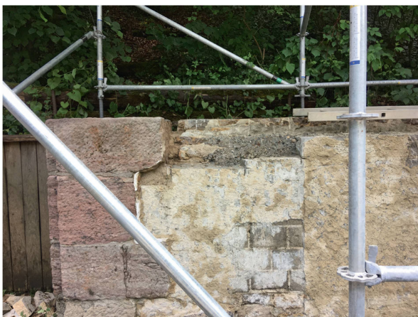
Abb. 14: Augst BL, Amphitheater (Monumentenrestaurierung 905.2020.01). Podiumsmauer, Ersatz von Vormauerungen und Abdichtung, Südwest-Abschnitt. Zustand westlich vom Südcarcer nach Beendigung der Abbrucharbeiten; die Rekonstruktion aus Zementsteinen und Beton ist nach dem Entfernen des Zementputzes gut erkennbar. Der obere Teil des Türgewändes aus Buntsandsteinquadern ist eine Rekonstruktion aus dem Jahr 1984.
