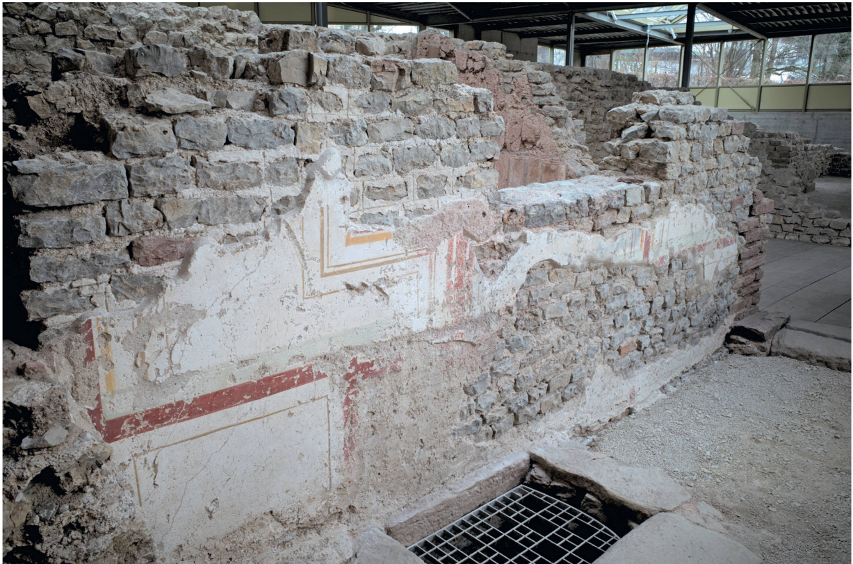
Abb. 35: Kaiseraugst AG, Gewerbehaus Schmidmatt (Monumentenrestaurierung 917.2020.02). Konservierung von Wandmalerei in situ (Couloir Raum 5). Die Ostwand von Raum 5 (MR 26) nach Beendigung der Konservierungsarbeiten an den Wandmalereien. Die 1993/1994 zum Teil grossflächig angebrachten Plextolmörtel sind vollständig entfernt und der Erhaltungszustand des Originals ist wieder klar ablesbar. Die Baustruktur hat so deutlich an Authentizität gewonnen.
