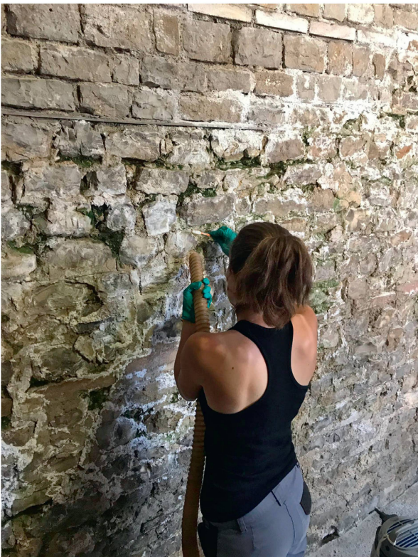
Abb. 22: Augst BL, Taberna (Monumentenrestaurierung 907.2020.01). Reinigung von Algen und starken Salzausblühungen. Als Sofortmassnahme wurden die Salze systematisch abgebürstet und abgesaugt und das Algenwachstum mit dem Aufsprühen von Ethanol bekämpft. Mittelfristig braucht es aber eine Intervention, die die Ursache des Übels, das ins Originalmauerwerk eindringende Hangwasser, beseitigt.
