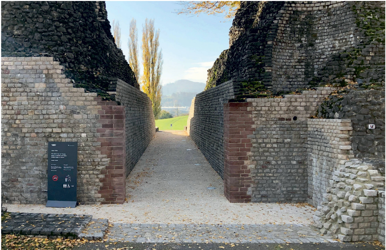
Abb. 43: Augst BL, Theater (Monumentenrestaurierung 924.2020.02). Umfassende Reinigungsarbeiten in den vomitoria und den aditus. Erscheinungsbild des Nordost-Vomitoriums nach vollständiger Reinigung mit Heissdampf. Der Boden ist von Erde und Moos befreit und lässt die Niederschläge wieder effizient versickern; die Wände sind von den schwärzlichen, die Feuchtigkeit speichernden Biopatina-Krusten befreit, haben aber dank der schonenden Reinigung ihre natürliche Patina bewahrt.
