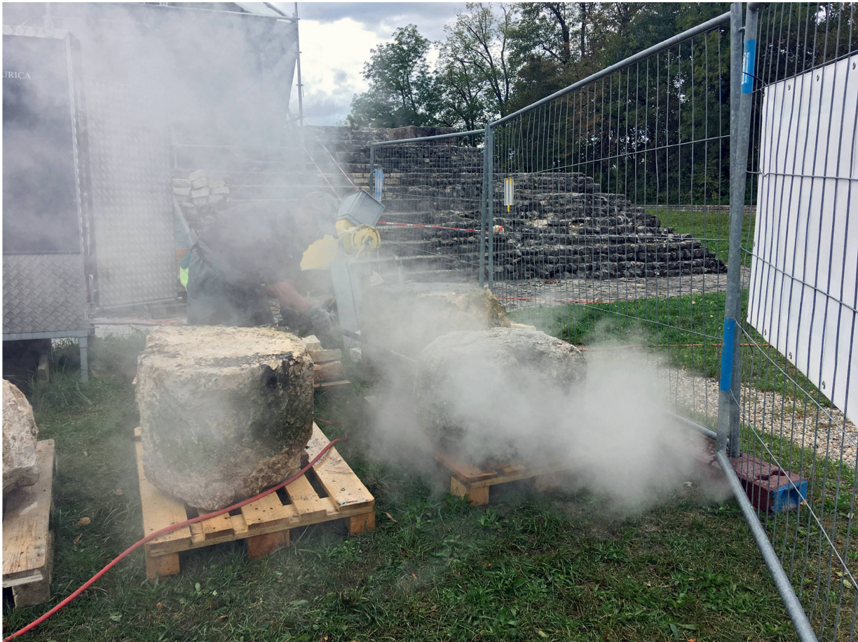
Abb. 12: Augst BL, Schönbühl (Monumentenrestaurierung 903.2020.03). Abbau der Architekturprobe aus dem 19. Jahrhundert. Die einzelnen Bauteile wurden vor Ort mit Heissdampf gereinigt, bevor deren Überführung ins schützende Steindepot erfolgte.
