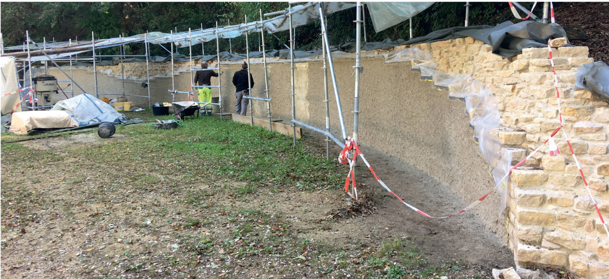
Abb. 19: Augst BL, Amphitheater (Monumentenrestaurierung 905.2020.01). Podiumsmauer, Ersatz von Vormauerungen und Abdichtung, Südwest-Abschnitt. Der restaurierte Mauerzug während des Anbringens von neuem, im feuchten Zustand noch grau erscheinendem Kalkputz. Eine komplette Erneuerung der Mauerschale in Naturstein war aus Kostengründen nicht möglich. In der unteren Hälfte musste daher die Vormauerung aus Zementsteinen aus den 1980er-Jahren belassen und mit einem neuen Verputz versehen werden. Beim 2020 angebrachten Verputz handelt es sich um einen diffusionsfähigen reinen Kalkputz. Durch den Mauerkörper versickerndes Wasser kann so an der Oberfläche besser austreten und kondensieren, ohne dass schwere Schäden am Mauerwerk entstehen. Flecken- und Salzbildung am Verputz wird aber auch zukünftig nicht zu vermeiden sein, da eine vollständige Isolation gegen hangseitig ins Mauerwerk eindringendes Sickerwasser nicht möglich ist.
