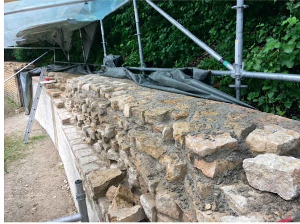
Abb. 17: Augst BL, Amphitheater (Monumentenrestaurierung 905.2020.01). Podiumsmauer, Ersatz von Vormauerungen und Abdichtung, Südwest-Abschnitt. Die neue Kernübermauerung und Abdeckung während des Aufbaus.
