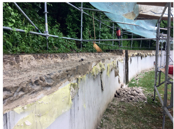
Abb. 15: Augst BL, Amphitheater (Monumentenrestaurierung 905.2020.01). Podiumsmauer, Ersatz von Vormauerungen und Abdichtung, Südwest-Abschnitt. Abbruch der oberen rekonstruierten Mauerzonen und des Zementputzes, der poröse Betonkern ist deutlich erkennbar.
