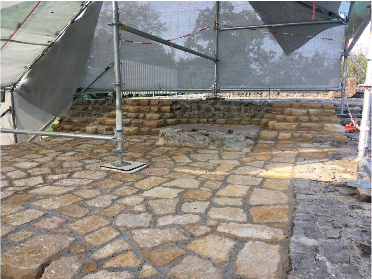
Abb. 10: Augst BL, Schönbühl (Monumentenrestaurierung 903.2020.02). Restaurierung der Stereobatenquader und der SE-Ecke des Tempelpodiums. Südostteil mit den in situ erhaltenen Quaderfundamenten nach Abschluss der Konservierungsarbeiten. Die Oberfläche ist in dieser Zone nun wieder dicht und die Niederschläge werden effizienter an den Mauerfuss abgeleitet, wo sie versickern können. Im Zentrum der im Kern des Podiums liegende, bereits 2019 neu konservierte Quaderstereobat.
