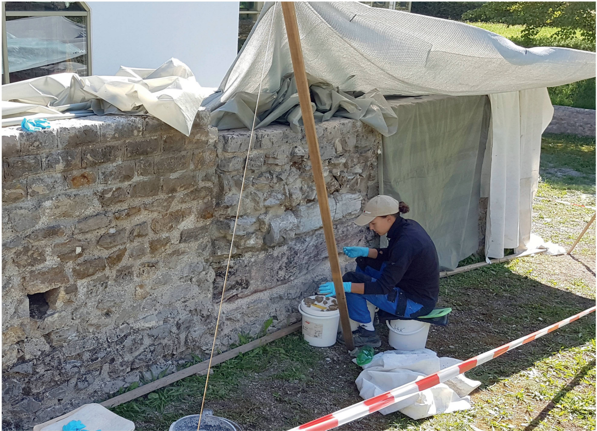
Abb. 32: Kaiseraugst AG, Gewerbehaus Schmidmatt (Monumentenrestaurierung 917.2020.01). Konservierung von Mauerzügen ausserhalb des Schutzbaus. Klebungs- und Verfügarbeiten durch Praktikantin Daria Jermann an der Westmauer von Raum 1. Der ausserordentlich heisse und trockene Sommer 2020 sorgte für zusätzliche Herausforderungen, denn beim Umgang mit dem Kalkmörtel erhöhte sich das Risiko von Rissbildung durch zu rasches Abtrocknen des Mörtels. Zudem bestand die Gefahr eines «Verbrennens» des Kalkmörtels durch zu grosse Hitzeeinwirkung infolge der direkten Sonneneinstrahlung. Die stark hitzeexponierte Lage dieses Teils der Ruine verlangte aber nicht nur den Baumaterialien, sondern auch den beiden Restauratorinnen einiges ab!
