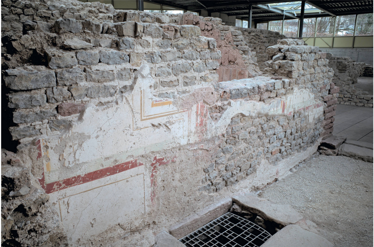
Abb. 35: Kaiseraugst AG, Gewerbehaus Schmidmatt (Monumentenrestaurierung 917.2020.02). Konservierung von Wandmalerei in situ (Couloir Raum 5). Die Ostwand von Raum 5 (MR 26) nach Beendigung der Konservierungsarbeiten an den Wandmalereien. Die 1993/1994 zum Teil grossflächig angebrachten Plextolmörtel sind vollständig entfernt und der Erhaltungszustand des Originals ist wieder klar ablesbar. Die Baustruktur hat so deutlich an Authentizität gewonnen.
