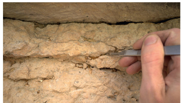
Abb. 7: Augst BL, Schönbühl (Monumentenrestaurierung 903.2020.02). Restaurierung der Stereobatenquader und der SE-Ecke des Tempelpodiums. Südliches in situ erhaltenes Quaderfundament: Reinigung von Rissen mit dem Skalpell. Die eingewachsene Vegetation führt mit ihrem Wurzelwachstum zur Ausdehnung der Mikrorisse und letztlich zum Absprengen ganzer Steinfragmente.
