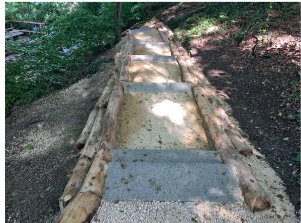
Abb. 3: Augst BL, Schönbühl (Monumentenrestaurierung 903.2020.01). Erosionssicherung am Nordabhang. Erneuerte und verbesserte Wegführung am Nordabhang des Schönbühls. Der Weg wurde leicht verflacht und stärker ins Gelände eingefügt.
