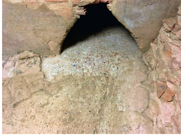
Abb. 25: Kaiseraugst AG, Rheinthermen (Monumentenrestaurierung 916.2020.01). Umfassende Reinigungsarbeiten. Unterboden des Hypokausts in gereinigtem (oben) und ungereinigtem (unten) Zustand.
