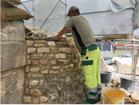
Abb. 8: Augst BL, Schönbühl (Monumentenrestaurierung 903.2020.02). Restaurierung der Stereobatenquader und der SE-Ecke des Tempelpodiums. Südliches in situ erhaltenes Quaderfundament während der Konservierungsarbeiten. Die Restaurierungen aus den 1960er-Jahren wurden belassen, wenn sie noch einigermaßen intakt waren. Lediglich rund um die Quaderfundamente wurden die alten Zementrestaurierungen vollständig entfernt, um die Wasserableitung zu verbessern und das Auswaschen von Chloriden in die originalen Kalksteinquader zu vermindern. Maurer Mladen Puklin beim Errichten der neuen Vormauerungen.
