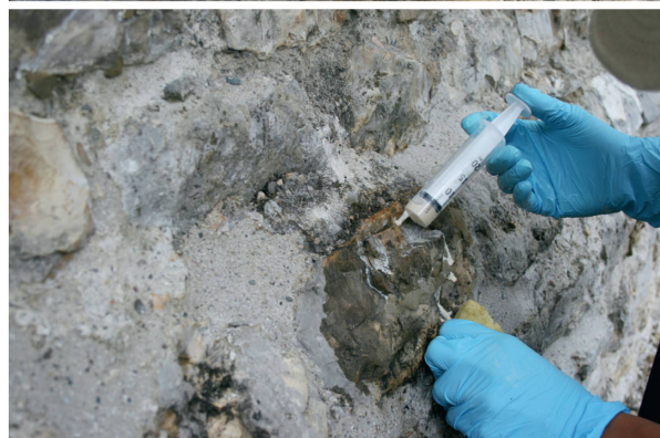
Abb. 31: Kaiseraugst AG, Gewerbehaus Schmidmatt (Monumentenrestaurierung 917.2020.01). Konservierung von Mauerzügen ausserhalb des Schutzbaus. Neukonservierung der originalen Mauerzüge: Nach Reinigung mit Schwamm und Bürste wurden die losen Teile der Handquader wieder angeklebt und die Risse mit einem sehr flüssigen Kalkmörtel gefüllt. Erst im Anschluss an diese Konsolidierung des Steinmaterials konnte der umliegende Portlandzement, sofern er nicht zu tief in die Fugen gepresst worden war, entfernt und durch einen weicheren und diffusionsfähigeren Kalkmörtel ersetzt werden.
