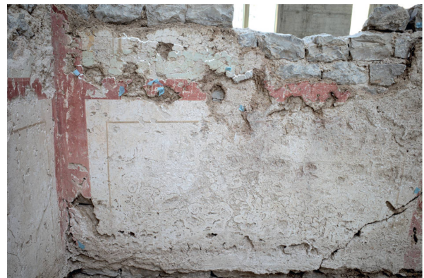
Abb. 37: Kaiseraugst AG, Gewerbehaus Schmidmatt (Monumentenrestaurierung 917.2020.02). Konservierung von Wandmalerei in situ (Couloir Raum 5). Mauer 21 während der Konservierungsarbeiten. Die blauen Markierungen bezeichnen abgelöste und neu wieder angelebte Malereifragmente.
