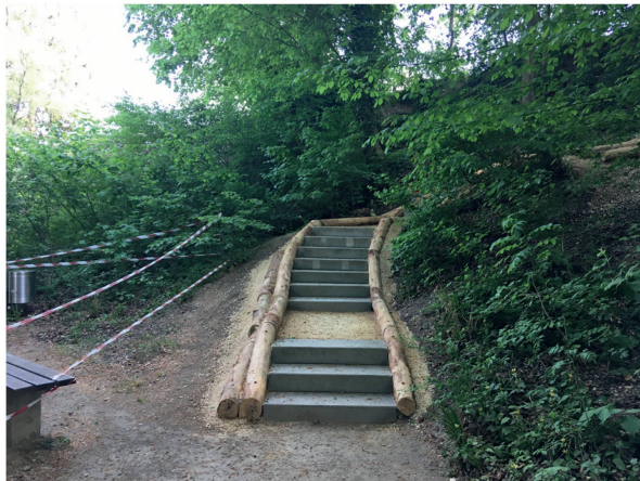
Abb. 2: Augst BL, Schönbühl (Monumentenrestaurierung 903.2020.01). Erosionssicherung am Nordabhang. Erneuerte und verbesserte Wegführung am Nordabhang des Schönbühls. Als Erosionssperre dienen massive Rundhölzer, die mit Eisen im Terrain verankert und untereinander verschraubt sind.
