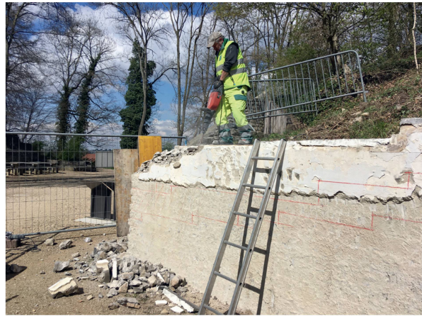
Abb. 4: Augst BL, Amphitheater (Monumentenrestaurierung 905.2021.01). Abbruch der oberen rekonstruierten Mauerzonen und des Zementputzes durch Mladen Puklin. Die Höhen der zukünftigen Aufmauerungen (Mauerschale und Kernübermauerung) sind rot angezeichnet.
