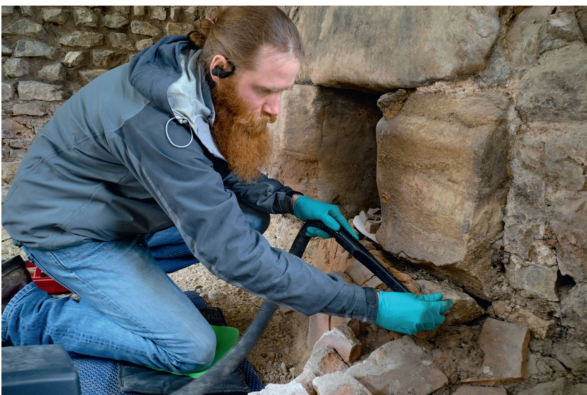
Abb. 37: Kaiseragust AG, Gewerbehaus Schmidmatt (Monumentenrestaurierung 917.2021.01). Anjo Weichbrodt beim Reinigen der Einfuerungsöffnung des Hypokausts als Vorbereitung für die nachfolgende Konsolidierung und Klebung der in der Konstruktion verbauten Ziegel.
