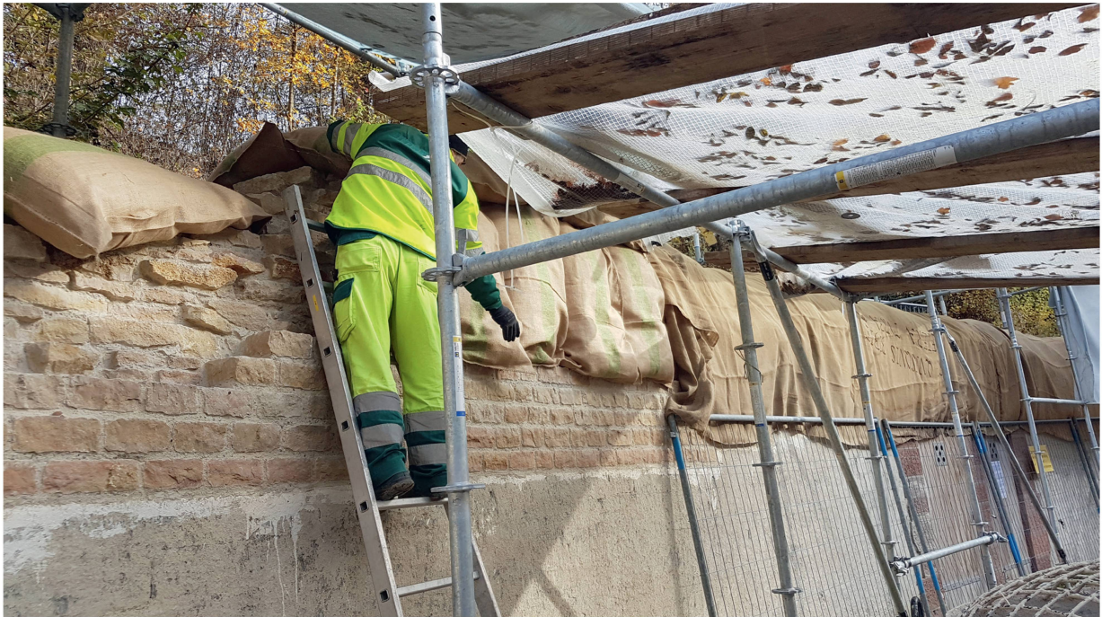
Abb. 2: Augst BL, Amphitheater (Monumentenrestaurierung 905.2021.01). Einrichtung des Kälteschutzes und der Einhausung, wie sie für den ersten Winter nach Fertigstellung, wenn das Mauerwerk noch nicht vollständig ausgetrocknet ist, notwendig ist, um Frostschäden zu vermeiden.
