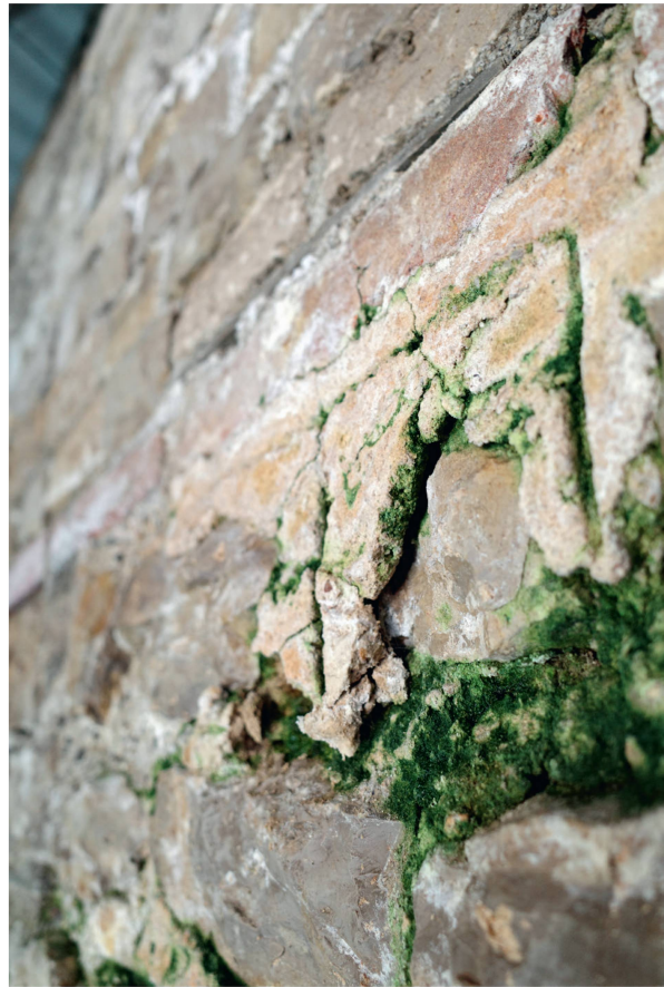
Abb. 24: Augst BL, Taberna (Monumentenrestaurierung 907.2021.01). Resultat der Durchfeuchtung durch die starken Regenfälle vom Juli 2021. Ein mehrere Millimeter dicker Algenteppich hatte sich grossflächig über die Wand gelegt und der originale Fugmörtel hatte vielerorts begonnen, sich ab- und aufzulösen.
