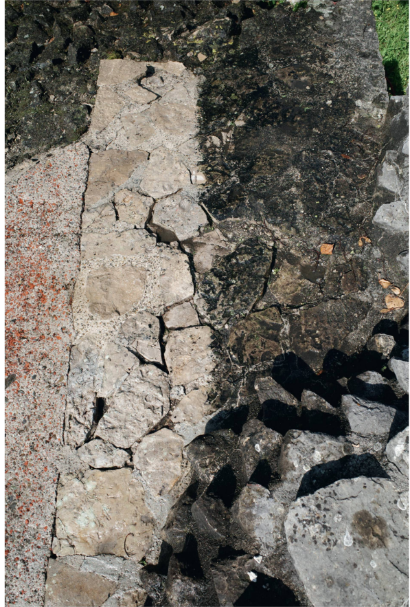
Abb. 34: Kaiseragust AG, Castrum Rauracense (Monumentenrestaurierung 915.2021.01). Hingegen sind die (zumeist modernen) Mauerüberdeckungen aus Kalkstein vielfach zerrissen und instabil. Sie bedürfen in den kommenden Jahren dringend einer durchgreifenden Restaurierung.
