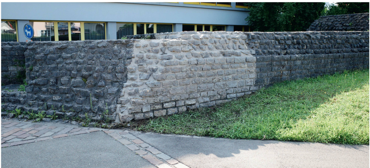
Abb. 31: Kaiseraugst AG, Castrum Rauracense (Monumentenrestaurierung 915.2021.01). Wie die Tests gezeigt haben, kann mit der Heissdampfmethode die für eine umfassende Dokumentation und eine detaillierte Zustandserfassung nötige Grundreinigung effizient durchgeführt werden. Ausserdem lässt sich damit auch die schädigende schwarze Biopatina recht problemlos und nachhaltig entfernen.
