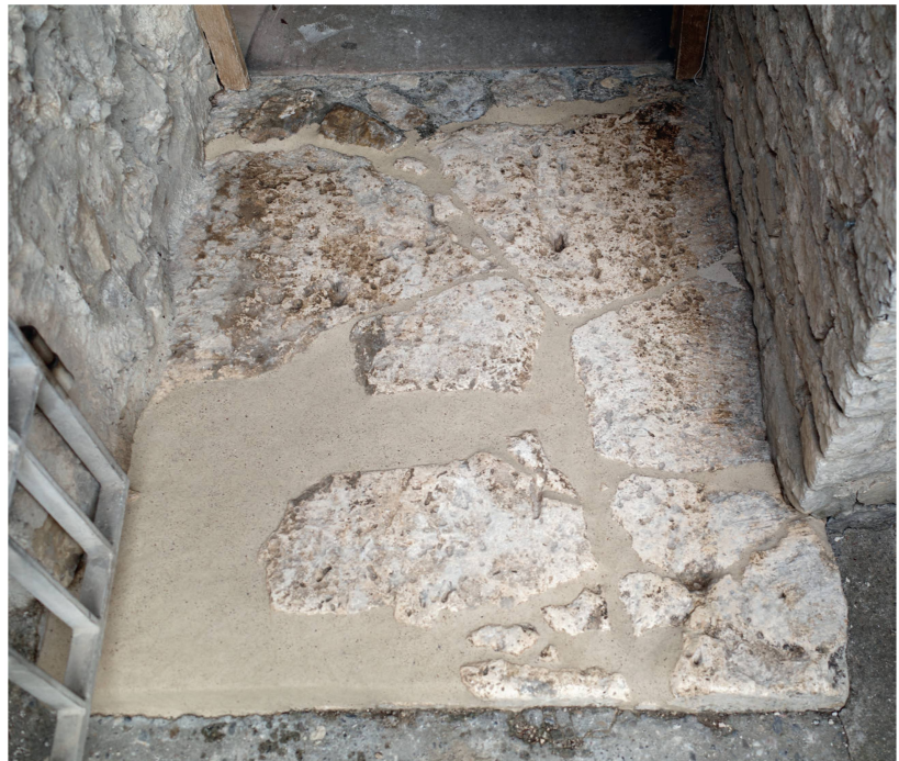
Abb. 19: Augst BL, Curia (Monumentenrestaurierung 906.2021.02). Fertiggestellte Neukonservierung der Kalksteinschwelle zum Curiakeller. Die Fehlstellen wurden zum besseren Schutz vor mechanischer Beanspruchung mit Kalkmörtel ergänzt. In Zukunft soll allerdings ein Metallgitter verhindern, dass die fast 2000 Jahre alte Steinschwelle weiterhin direkt begangen wird.
