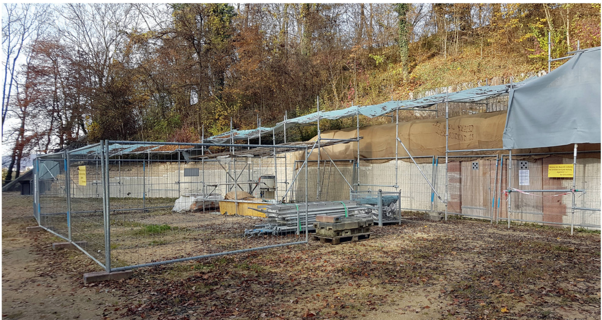
Abb. 3: Augst BL, Amphitheater (Monumentenrestaurierung 905.2021.01). Partiiell fertiggestellte Einhausung für den Winter. Die Abdeckung mit Jute und Plastikplanen sowie auf die neue Mauerkrone aufgelegte, mit Holzwolle gefüllte Säcke verhindern, dass direkte Feuchtigkeit und Frost den noch nicht vollständig ausgetrockneten Mörtel schädigen. Die unterhalb der erneuerten Aufmauerungen sichtbare Betonschale der Rekonstruktion aus den 1980er-Jahren wird nach Austrocknung der neuen Mauerteile im Verlauf des Jahres 2022 noch mit einem optisch ansprechenderen beige Kalkputz versehen.
