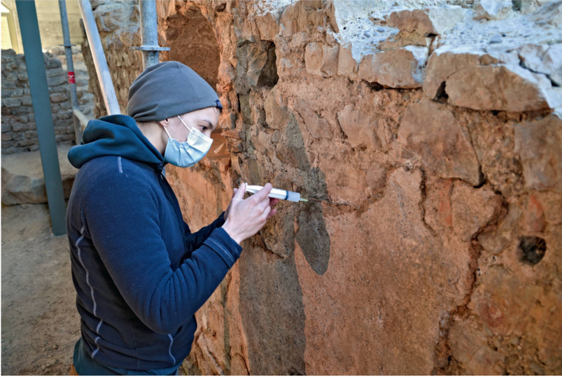
Abb. 36: Kaiseragust AG, Gewerbehaus Schmidmatt (Monumentenrestaurierung 917.2021.01). Sicherung des originalen beigen Wandverputzes in Raum 2 durch Injektion von Nanokalk.
