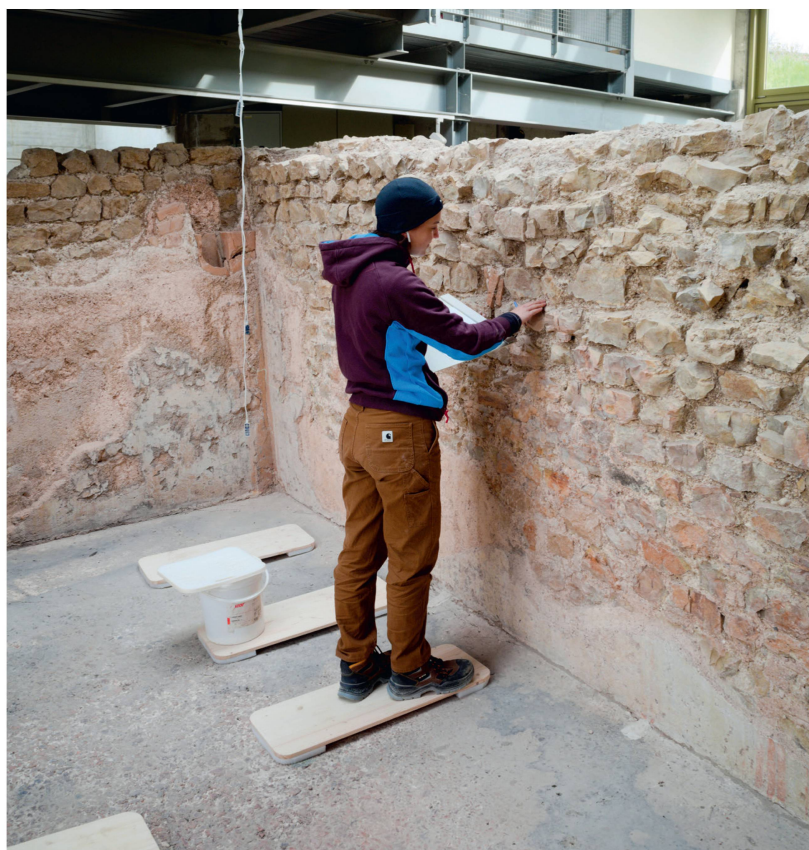
Abb. 35: Kaiseraugst AG, Gewerbehau Schmidmatt (Monumentenrestaurierung 917.2021.01). Konservierung von Wandmalerei und Putzen in den Räumen 2 und 6 (MR 7 und MR 11). Daria Jermann bei der Schadensaufnahme im hypokaustierten Raum 6.
