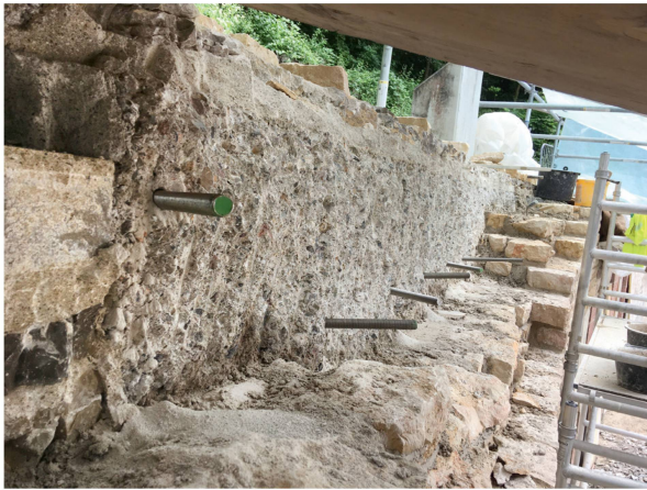
Abb. 6: Augst BL, Amphitheater (Monumentenrestaurierung 905.2021.01). Beginn der Kernmauerung für die neue Überkronung. Zur Verbesserung der Verbindung sind Fiberglasanker in den bestehenden Betonkern eingelassen.
