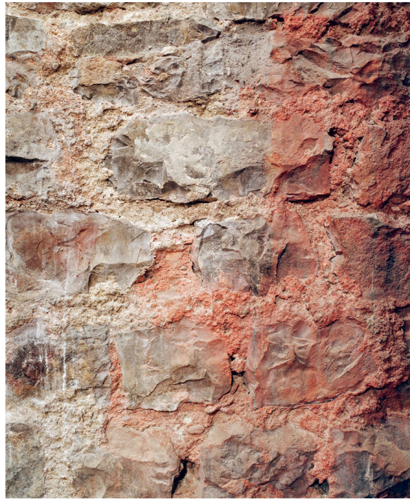
Abb. 21: Augst BL, Curia (Monumentenrestaurierung 906.2021.03). Testfläche zu Beginn der Reinigungsarbeiten. Der Effekt der Reinigung mit Heissdampf (Mauerabschnitt links im Bild) ist deutlich sichtbar und zeigt, dass die Methode die nötige Effizienz erbringt.
