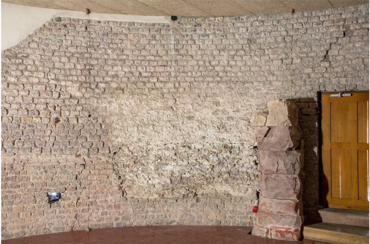
Abb. 12: Augst BL, Curia (Intervention 2021.066). Innenraum, Blick auf die Fensterzumauerung in Abschnitt MR 1g, unmittelbar östlich der modernen Eingangstür (Beilage 1,33–35). Zwischen der Tür und der Zumauerung des Fensters ist der vor die Mauer MR 1 gestellte Werksteinpfeiler erkennbar (Beilage 1,23), der abgesehen vom obersten erhaltenen Kalksteinquader ausschliesslich aus Buntsandstein besteht.
