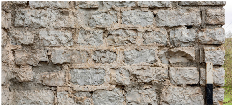
Abb. 7: Augst BL, Curia (Intervention 2021.066). Blick von Süden an Stützpfiler MR 7c mit erhaltenen Resten der Pietra-Rasa-Oberfläche und eingeritzten Fugenstrichen.
