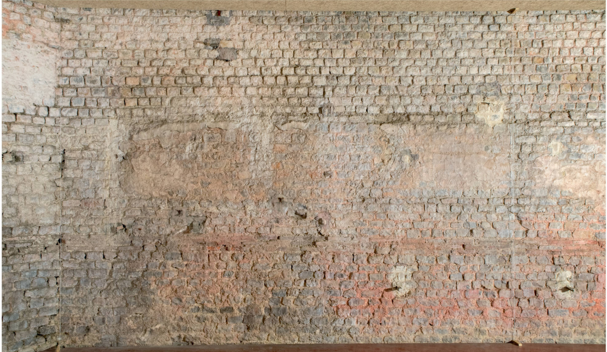
Abb. 17: Augst BL, Curia (Intervention 2021.066). Innenraum, Blick von Nordosten auf die rückwärtige Curiamauer MR 9. Links im Bild die Verbindung zur Tambourmauer MR 1 (mit sekundärer Einzahnung von MR 9 in der unteren Hälfte), rechts endet der Bildausschnitt knapp vor dem grossen, wegen seines Gewichts einstweilen noch an der Wand befestigten Bodenmosaik aus Insulae 41/47 (Beilage 2A; vgl. Abb. 33).
