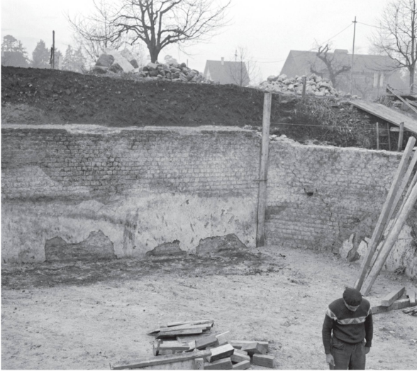
Abb. 8: Augst BL, Curia (Intervention 1961.060). Foto während der Freilegung des Curiainnern im Jahre 1961. Blick von innerhalb an die rückwärtige Curiamauer MR 9 und die nordwestliche Ecke, gebildet aus MR 1 und MR 9. Gut erkennbar sind die zu diesem Zeitpunkt noch grossflächig erhaltenen weissen Verputzreste an den verschiedenen Mauern. Das römische Gelniveau liegt noch ca. 1,60 m tiefer.
