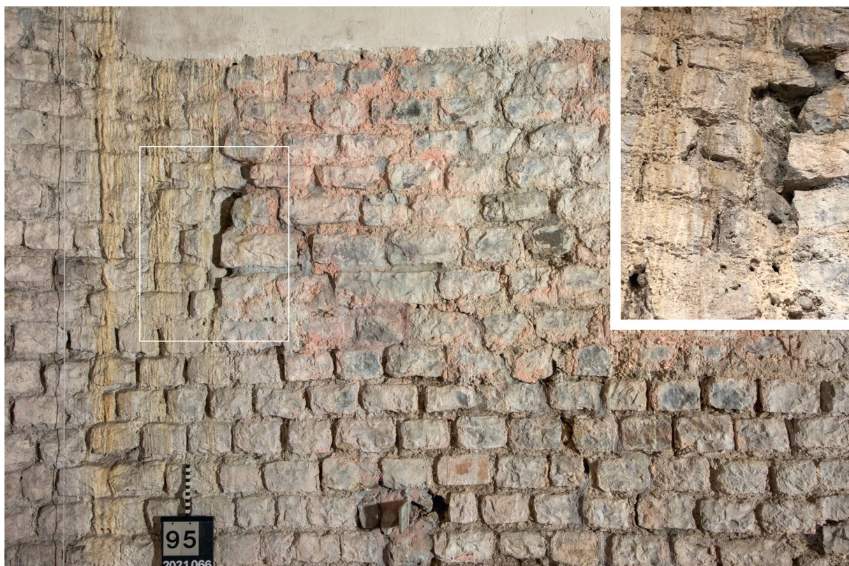
Abb. 28: Augst BL, Curia (Intervention 2021.066). Innenraum, Blick von Osten an die vertikale fünfflagige Baufuge mit der abgelenkten, schräg hinter die Tambourmauer MR 1 ziehenden jüngeren Basilicastützmauer im Abschnitt MR 1a (Beilage 1,41). Baubefund im Mauerkontext und Detailauszug (Bildausschnitt rechts) mit der unbiegenden Basilicastützmauer und dem nachträglich daran angefügten oberen Bereich der Tambourmauer MR 1.
