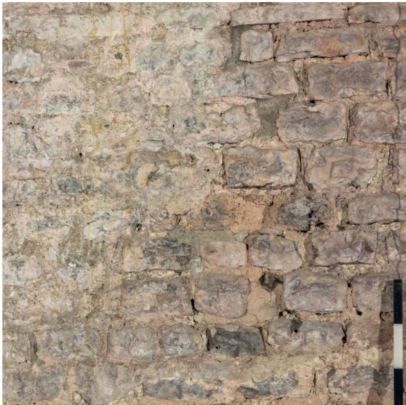
Abb. 14: Augst BL, Curia (Intervention 2021.066). Innenraum, Blick von Südwesten auf die südöstliche untere Ecke der Fensterzumauerung (Fenster 2) in Abschnitt MR 1e (Beilage 1,32). Eine Schneiderfuge und der Deckstein aus Quelltuff lassen das über zwei Steinlagen reichende antik zugemauerte Balkenloch erkennen (Beilage 1,11).
