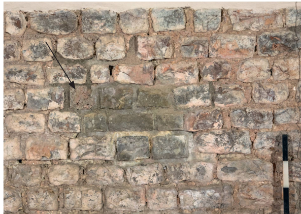
Abb. 15: Augst BL, Curia (Intervention 2021.066). Innenraum, das modern zugemauerte Balkenloch in Abschnitt MR 1d (Beilage 1,9) kann in Übereinstimmung mit den anderen modern zugemauerten Balkenlöchern in diesem Mauerbereich (Beilage 1,7–9) dank des Rests des Tuffdecksteins, der Höhenlage und der Position im Verhältnis zum nächst liegenden Stützpfiler eindeutig identifiziert werden (Pfeil). Tuffsteine finden sich bei der Curia ausschliesslich in Verwendung als Decksteine für Balkenlöcher. Die moderne Zumauerung der Balkenlöcher erfolgte vermutlich im Zusammenhang mit den Restaurierungsarbeiten der frühen 1960er-Jahre.
