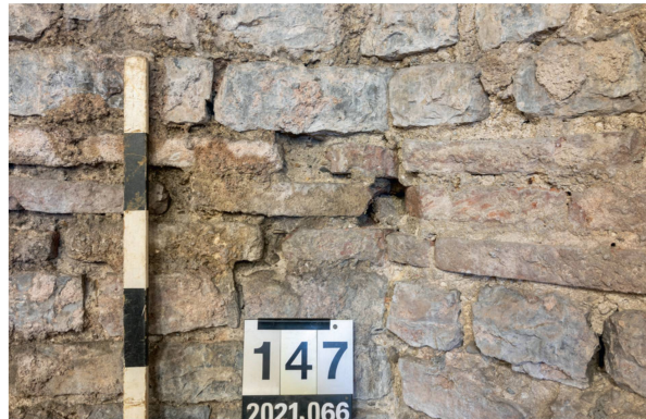
Abb. 19: Augst BL, Curia (Intervention 2021.066). Innenraum, Detailaufnahme des Eckverhältnisses der Ziegelbänder von MR 1m und MR 9. Der Ziegel der mittleren Ziegellage von MR 1m (links) wurde partiell ausgebrochen, um an dieser Stelle das Ziegelband von MR 9 (rechts) einzuzahnen zu können. Wie der Mörtelstopfen an der Ausbruchstelle zeigt, kam es, zumindest auf Ebene der Mauer-schalen, aber trotzdem nicht zu einem richtigen Verband, sodass MR 9 hier an MR 1m anstösst.
