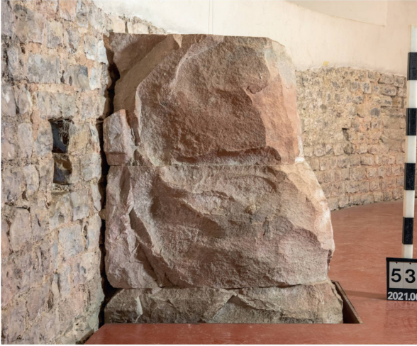
Abb. 27: Augst BL, Curia (Intervention 2021.066). Innenraum, Blick von Südwesten an den nördlichen Sandsteinstützpfiler MR 11 (vgl. Abb. 5; Beilage 1,22). Gut zu erkennen ist die breite Fuge zwischen Pfeiler und hinterdurchlaufender Tambourmauer MR 1, links daneben ein offenes Balkenloch (Beilage 1,5).
