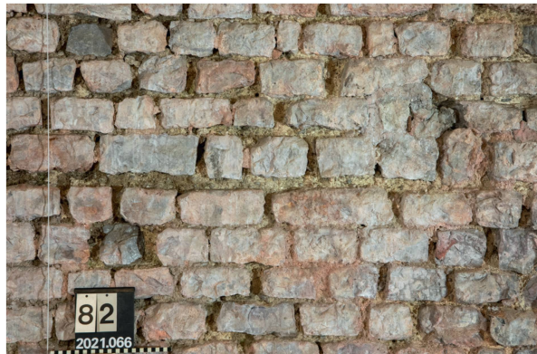
Abb. 16: Augst BL, Curia (Intervention 2021.066). Innenraum, Detailaufnahme der breiten Mörtelfuge (Beilage 1,21) im ursprünglichen Mauerwerk des Tambours MR 1 (hier der Bereich in Abschnitt MR 1m). Die vertikal gespannte Schmur entspricht der Mittelachse HP 17 (Beilage 1) von Stützpfiler MR 10.
