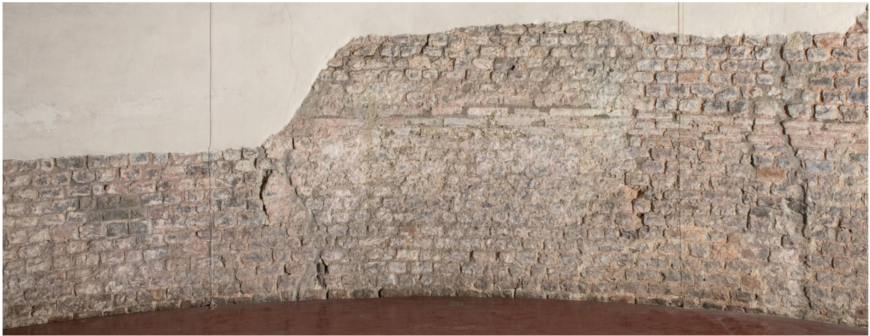
Abb. 9: Augst BL, Curia (Intervention 2021.066). Innenraum, Blick von Westen auf die antik zugemauerte Fensteröffnung (Fenster 2) im zentralen Mauerabschnitt MR 1e. Die vertikal gespannten Schnüre markieren die Mittelachsen der aussen gelegenen Stützpfiler MR 5 und MR 6.
