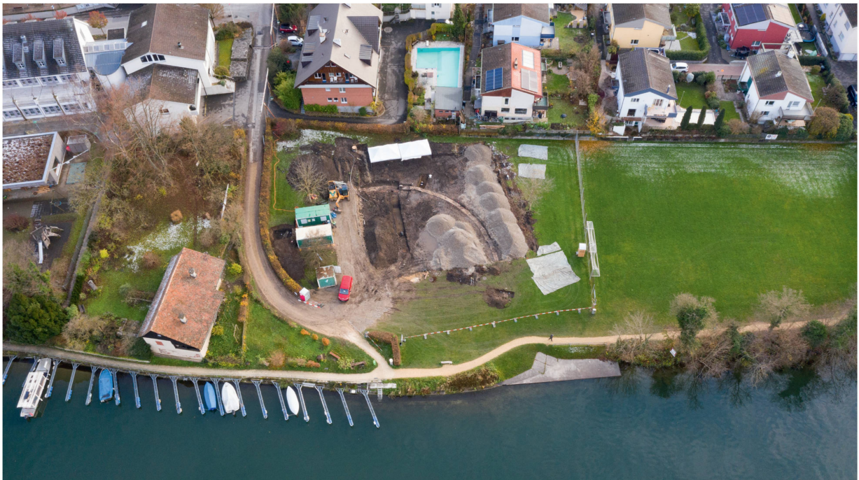
Abb. 3: Kaiseraugst AG, Bootshaus Basler Ruderclub (Begleitung 2021.016). Drohnenaufnahme der Baubegleitung im Dezember 2021.
