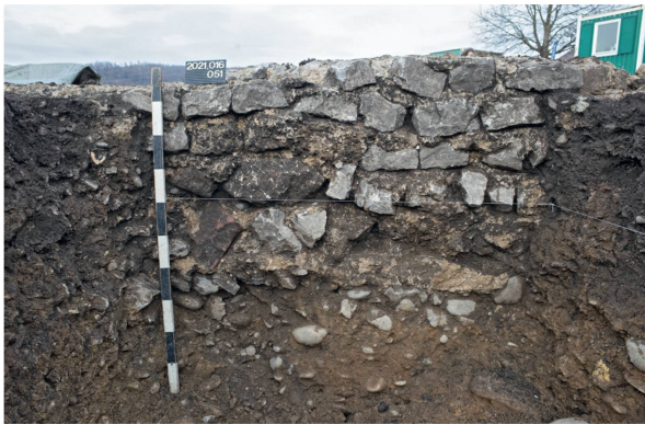
Abb. 10: Kaiseraugst AG, Bootshaus Basler Ruderclub (Begleitung 2021.016). Ansicht des Fundamentaufbaus der Podiumsmauer Pos 4. Unter dem Fundament ist die Steinbruchrückverfüllung Pos 3 zu erkennen.
