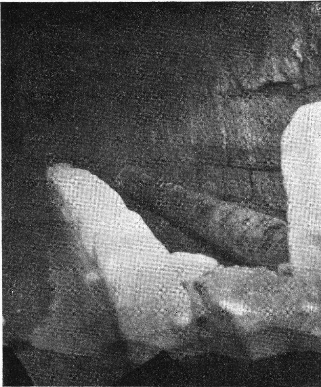
Abb. 38. Römische Wasserleitung in St. Maurice.
