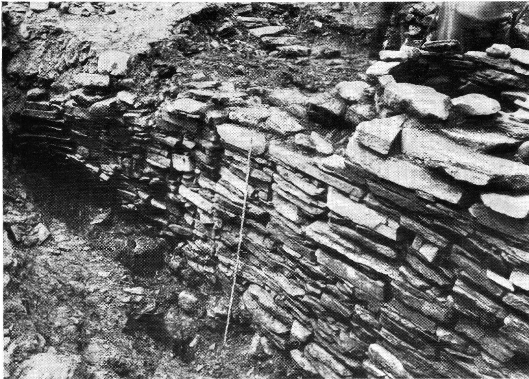
Taf. VII, Abb. 1. Crestaulta-Lumbrein. Die große Stützmauer (S. 82) Aus Jbr. Hist.-Ant. Ges. Graubünden 1939
