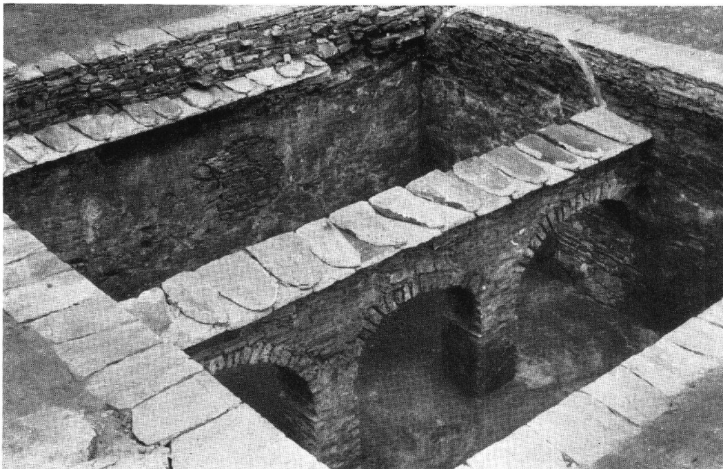
Tafel XIII, Abb. 2 Tegna-Castello. Blick in den Kellerraum mit Gewölbeansätzen (S. 95)
