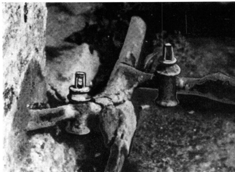
Tafel 10 A. Pompeji, Installation von Auslaufhähnen im Haus der Vettier.
