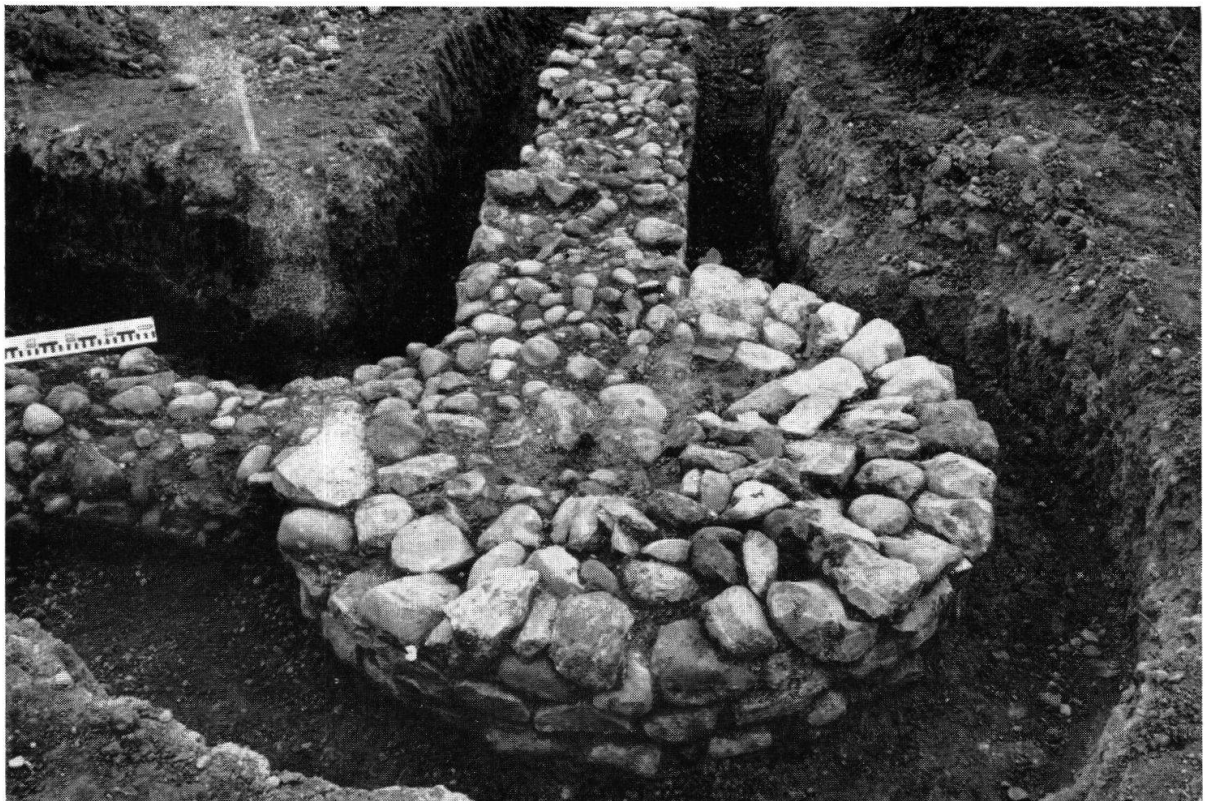
Tafel 12 B. Winkel ZH, Seeb. Römischer Gutshof, Ausgrabung 1958, Bau D. Nordecke aus Nordost.
