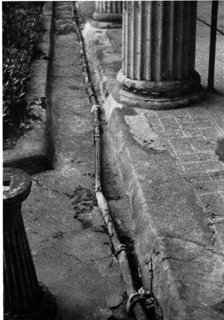
Tafel 10 B. Pompeji, Montage von Wasserrohren im Hause der Vettier (S. 62).
