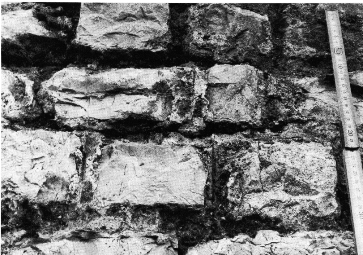
Tafel 17. Kaiseraugst AG. 1 Nicht streng durchgeführter Spitzfugenstrich – 2 Vertiefter, schmaler Rundfugenstrich.
