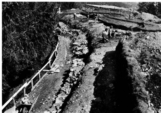
Abb. 38. Castiel GR, Carschlingg 1976. Spätromische Umfassungsmauer am Nordhang.
